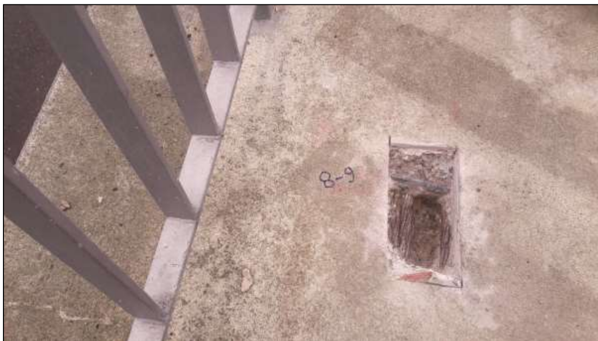
Foto 97: Pohled na otevřenou semidestruktivní sondu ke kabelům „systému A“ v levé rýze, prefabrikát 8-9, kabely L 1-2
