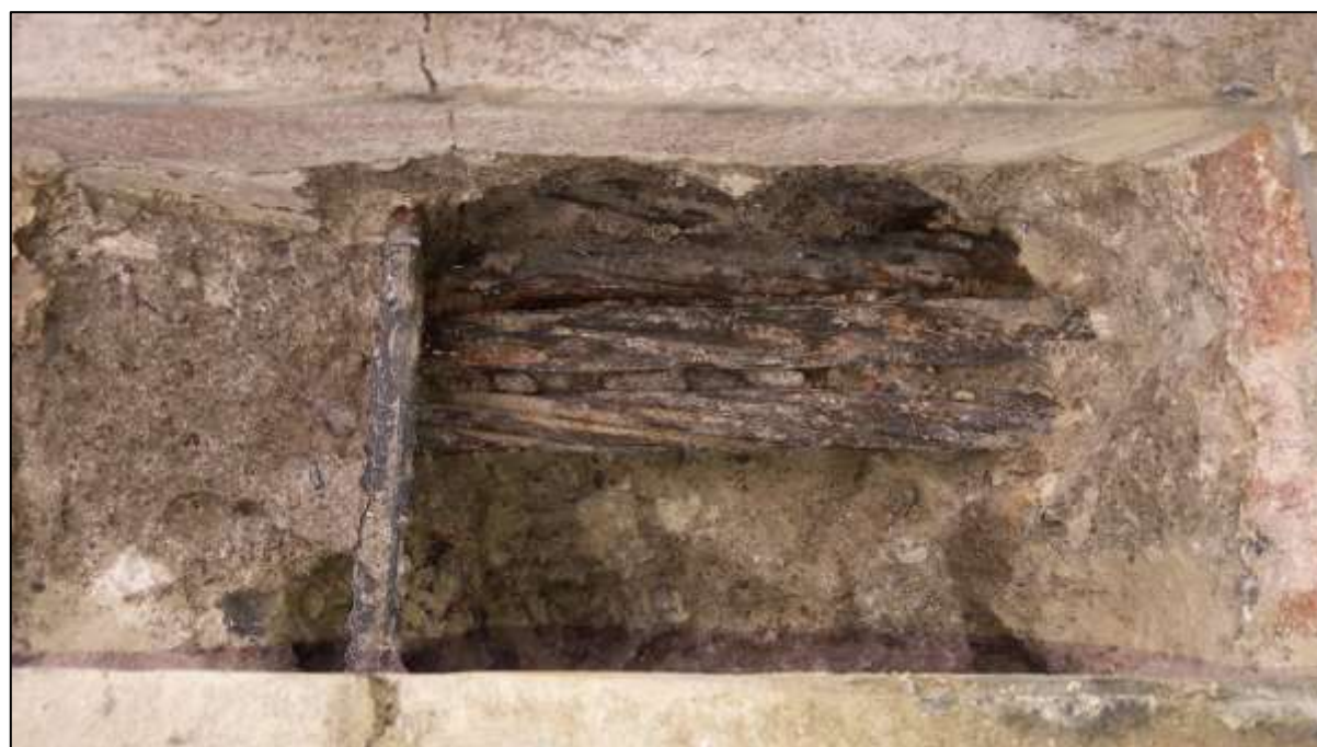
Foto 76: Bližší pohled shora na výrazné korozní napadení lana P 3 v sondě
