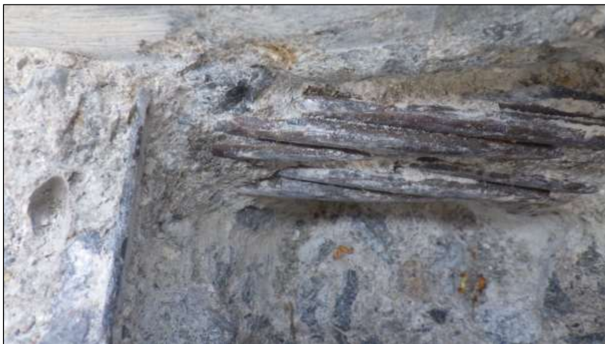
Foto 117: Bližší boční pohled na korozní stav odkrytých předpínacích lan kabelu L 1, nesouvislá povrchová koroze, lokálně počínající propagace koroze ze štěrbiny mezi patentovými dráty
