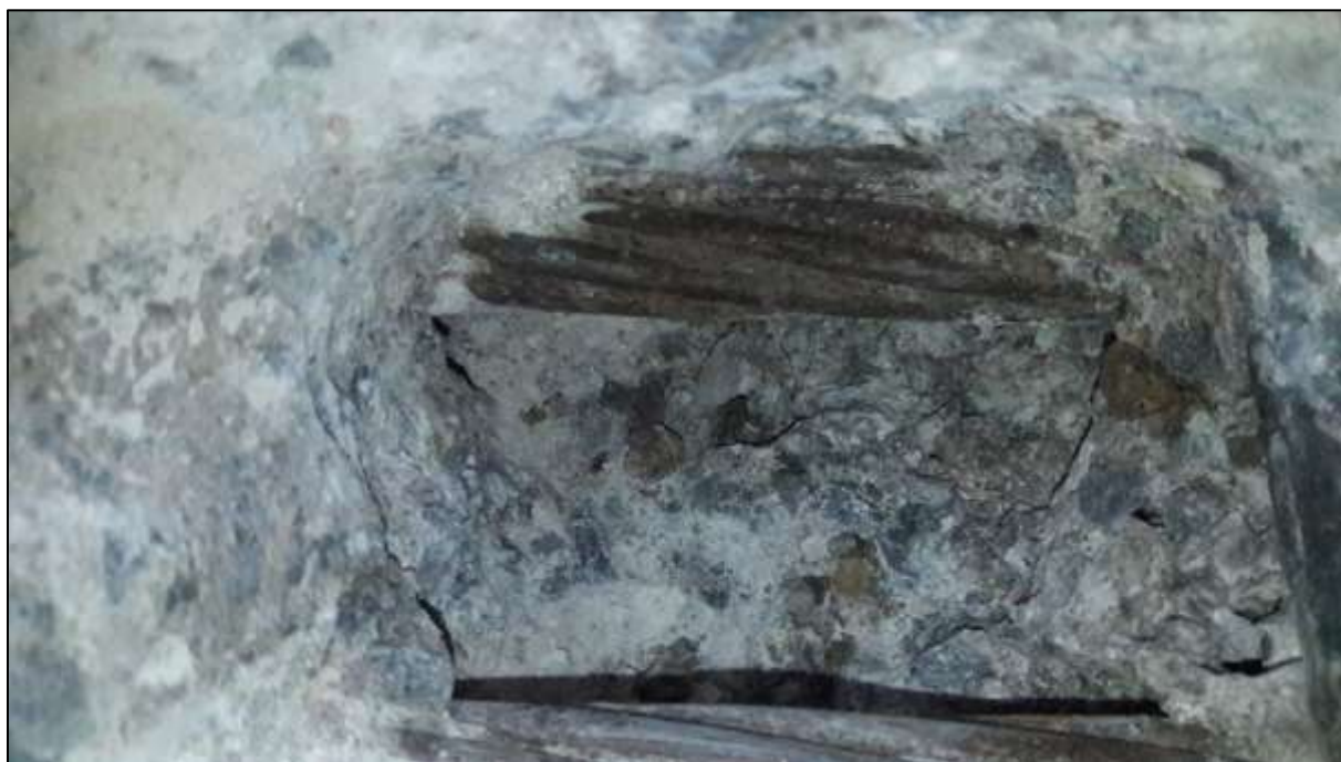
Foto 105: Bližší pohled na korozní stav odkrytých předpínacích lan kabelů P 2 a 3, nesouvislá povrchová koroze, místy důlková, nehtný a trhlinami porušený výplňový beton rýhy mezi nimi
