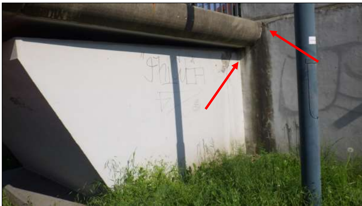
Foto 34: Spára 1, pohled zpět na stopy dlouhodobého zatékání na kotevním bloku, (opěra1) a navazujícím kolmém křídle, levá strana lávky - Zálabí
