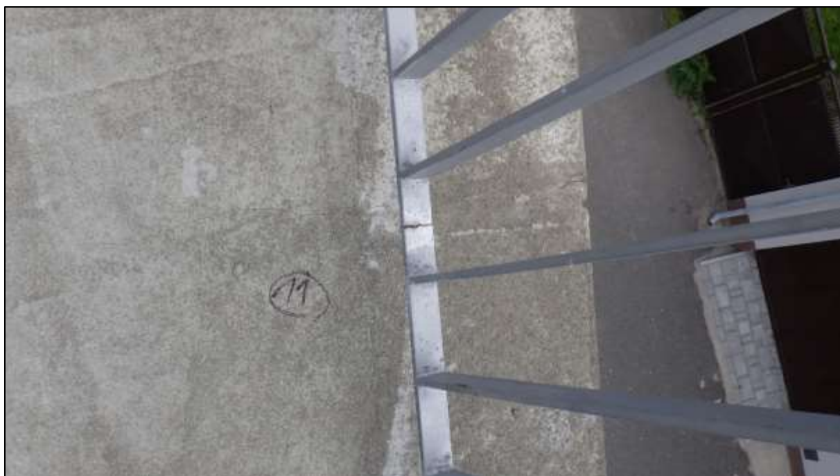
Foto 12: Obdobný stav s trhlinou stěrky a prasklým svarem v pravé části spáry č.11
