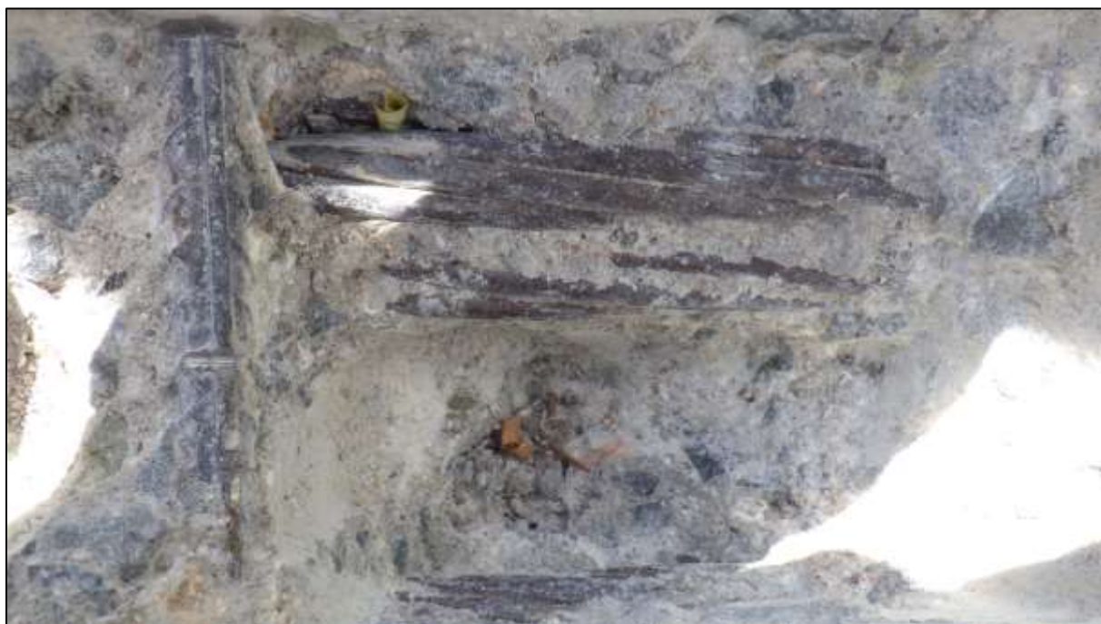
Foto 142: Pohled na otevřené semidestruktivní sondy ke kabelům „systému A“ v levé rýze, zleva - spára 69, kabely L 1-2, nesouvislá povrchová koroze
