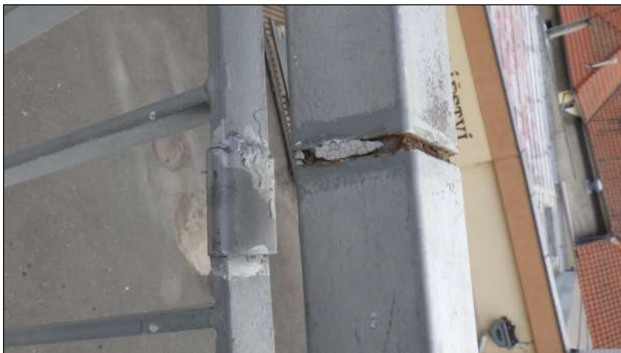
Foto 7: Pohled na typický stav deformovaného zábradlí – dilatace madla a horní pásnice výplně
