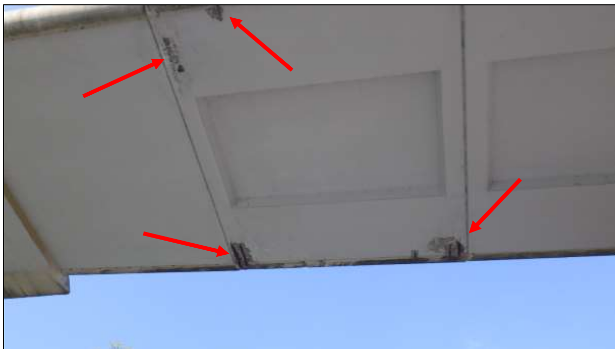
Foto 33: Bližší pohled na stav podhledu pravděpodobně nejvíce porušeného prefabrikátu 13-14, korozi měkké betonářské výztuže
