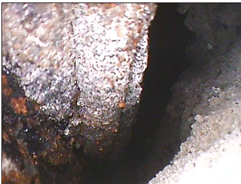
Foto 89: Detailní pohled na lana kabelu P2, patrná koroze patentových drátů, směr spára 3, délka dutiny cca 10 cm od horní sondy
