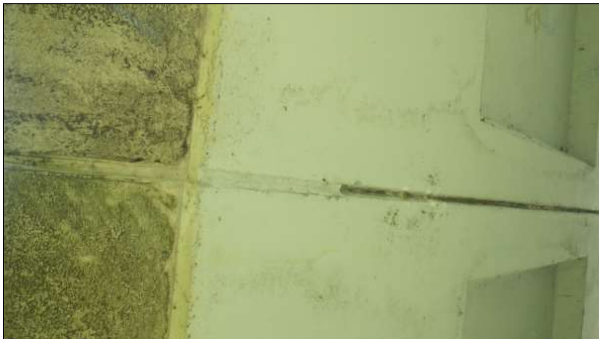
Foto 27: Pohled na výluhy a krápníčky na podhledu spáry 66 vlevo
