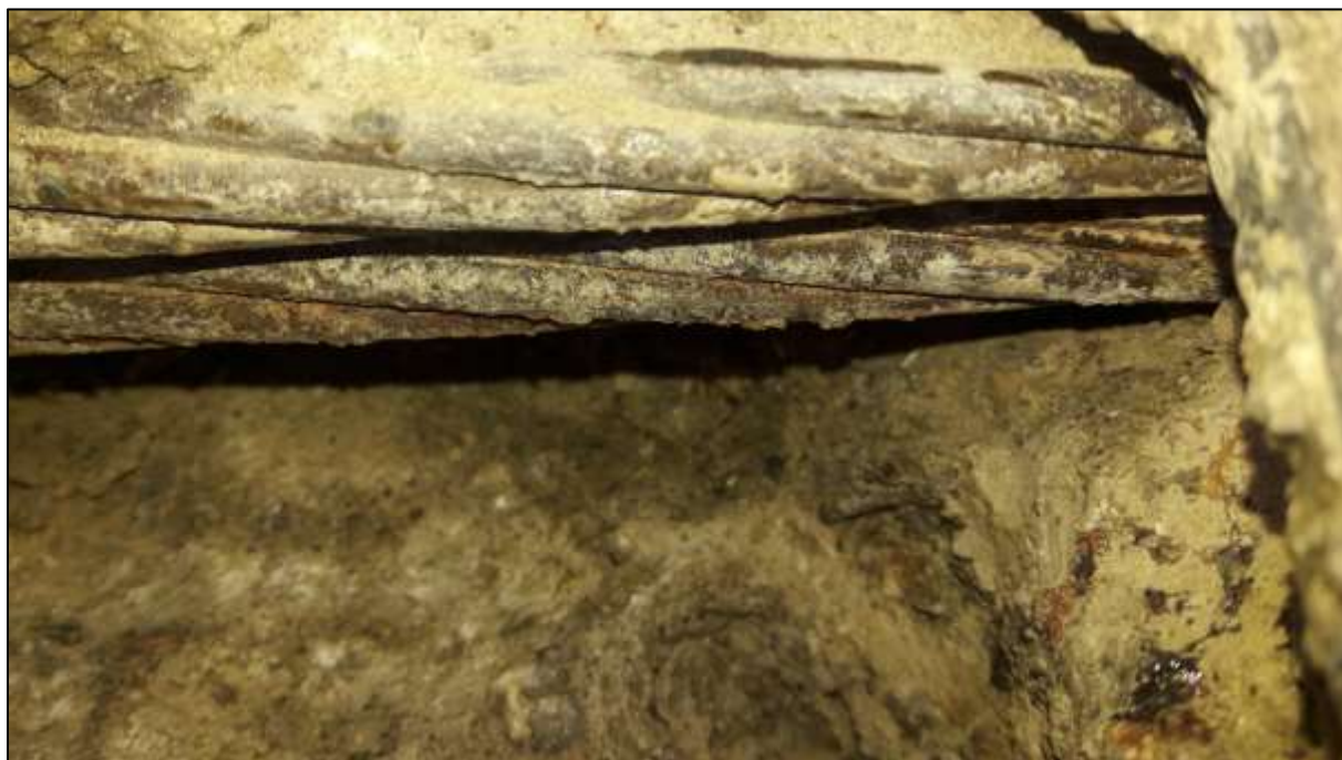
Foto 75: Bližší pohled na výrazné korozní napadení lana P 3 v sondě a dutinu pod ním
