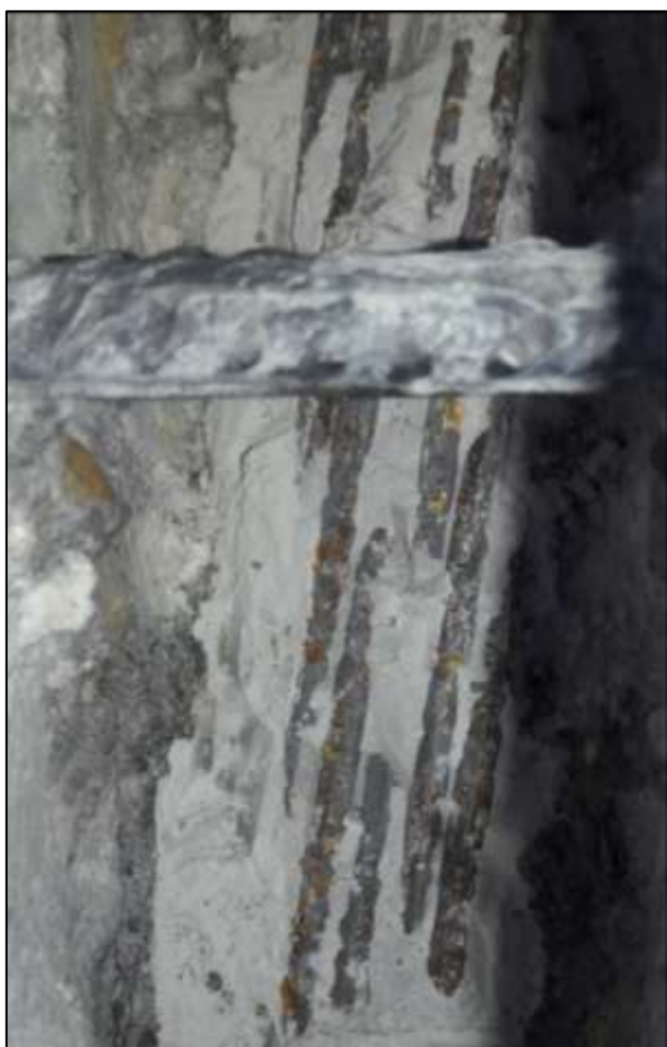
Foto 47: Pohled na povrch patentových drátů po odběru vzorku injektážní hmoty, pouze bodové stopy povrchové koroze
