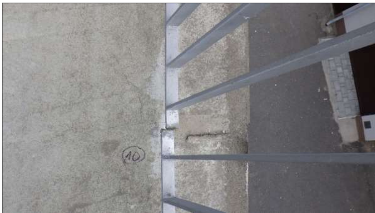
Foto 10: Pohled na typickou poruchu stěrky na pravé straně příčné spáry č.10 a prasklý svár spodní pásnice výplně zábradlí s příčným posunem obou částí
