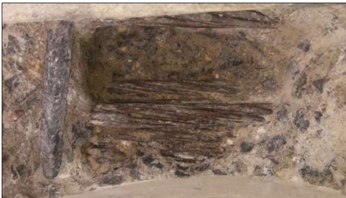
Foto 96: Zvýraznění barevného kontrastu po navlhčení povrchu odkrytých předpínacích lan kabelů P 1 a 2, lokální povrchová koroze, místy důlková
