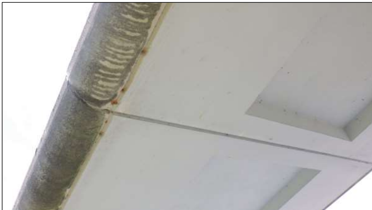
Foto 20: Pohled na typické projevy koroze betonářské výztuže prefabrikátů (vylehčených) v odkapové drážce zespodu (pravá strana pole 1-2)
