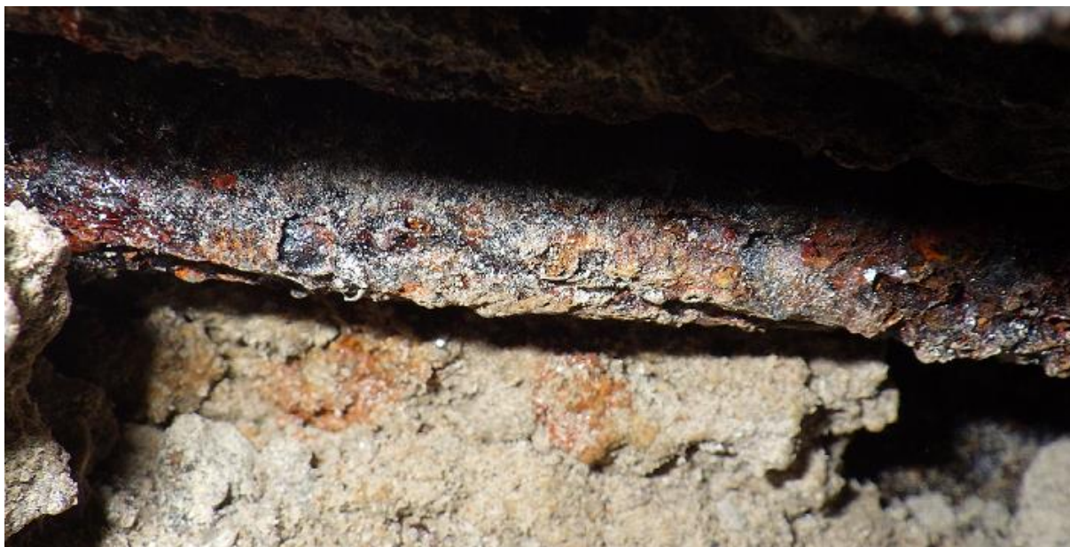
Obr. 3. Vzhled odhaleného korozně nejintenzivněji napadeného lana („systém A“, spára 2, kabel P3)
