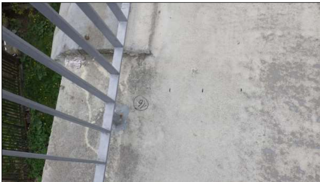
Foto 13: Pohled na levou stranu spáry č.16 – napojení prefabrikátu na monolitické sedlo pilíře 2, s vyznačením polohy os předpínacích kabelů („systému A“) v krajní rýze
