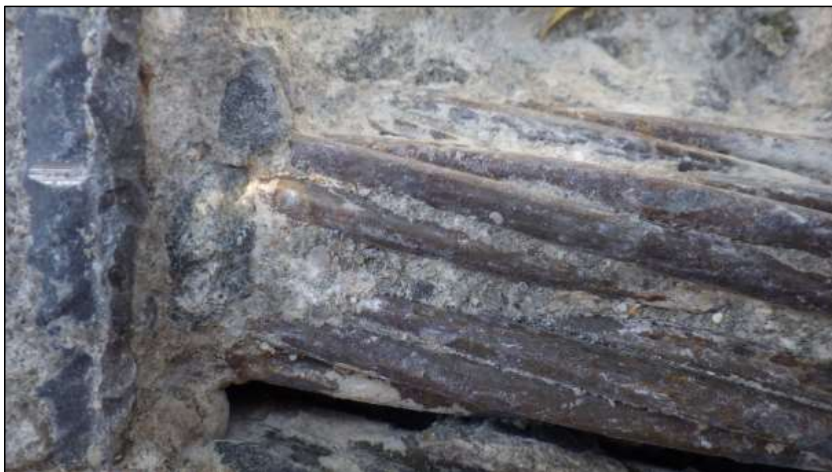
Foto 119: Bližší boční pohled na korozní stav odkrytých předpínacích lan kabelu L (sonda L 2-3), nesouvislá povrchová koroze, lokálně počínající propagace koroze ze štěrbin mezi patentovými dráty
