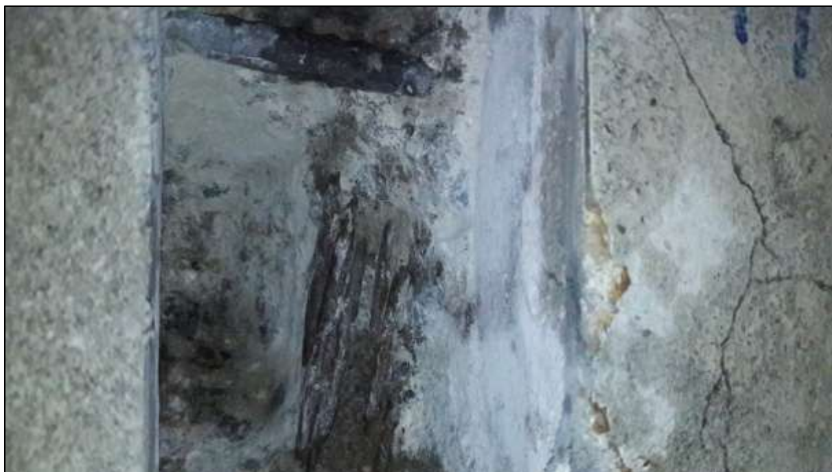
Foto 109: Bližší pohled na korozní stav odkrytých předpínacích lan kabelu L2, pouze nesouvislá povrchová koroze
