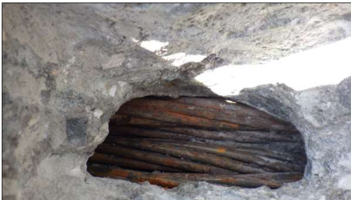
Foto 65: Pohled na kabel v nezainjektovaném kanálku 14, viditelné stopy koroze na povrchu předpínacích lan
