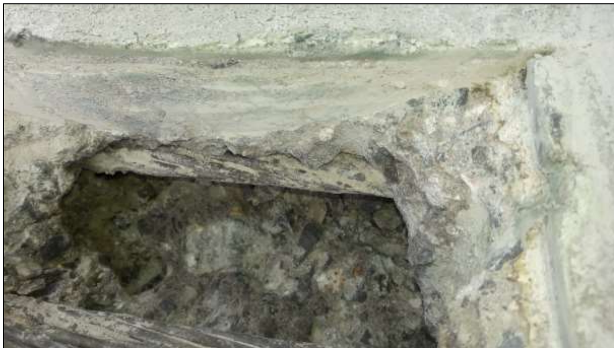
Foto 69: Bližší pohled na korozní stav kabelů L 2 a 3, pouze nevýrazná lokální povrchová koroze
