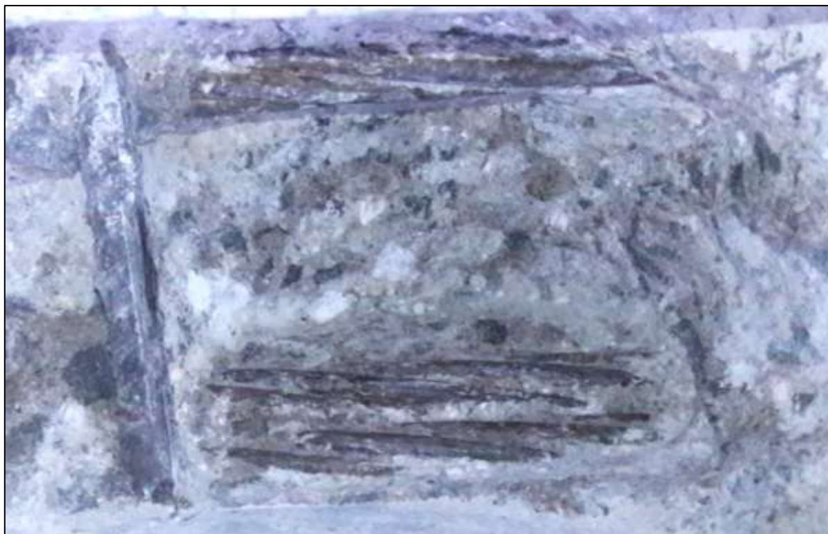
Foto 112: Bližší pohled na korozní stav odkrytých předpínacích lan kabelů P 2-3, pouze nepatrná lokální povrchová koroze
