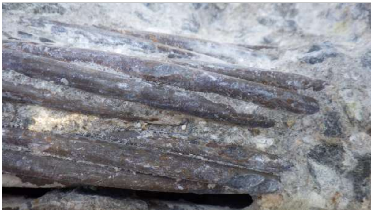
Foto 120: Bližší pohled na korozní stav odkrytých předpínacích lan kabelu L 3, nesouvislá povrchová koroze, místy slabá propagace koroze ze štěrbin mezi patentovými dráty
