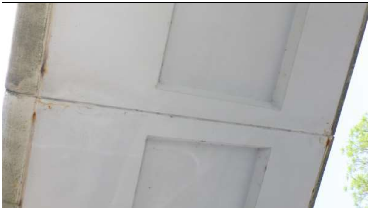
Foto 26: Viditelné stopy průsaků a rozvoj koroze na podhledu v oblasti spáry 56
