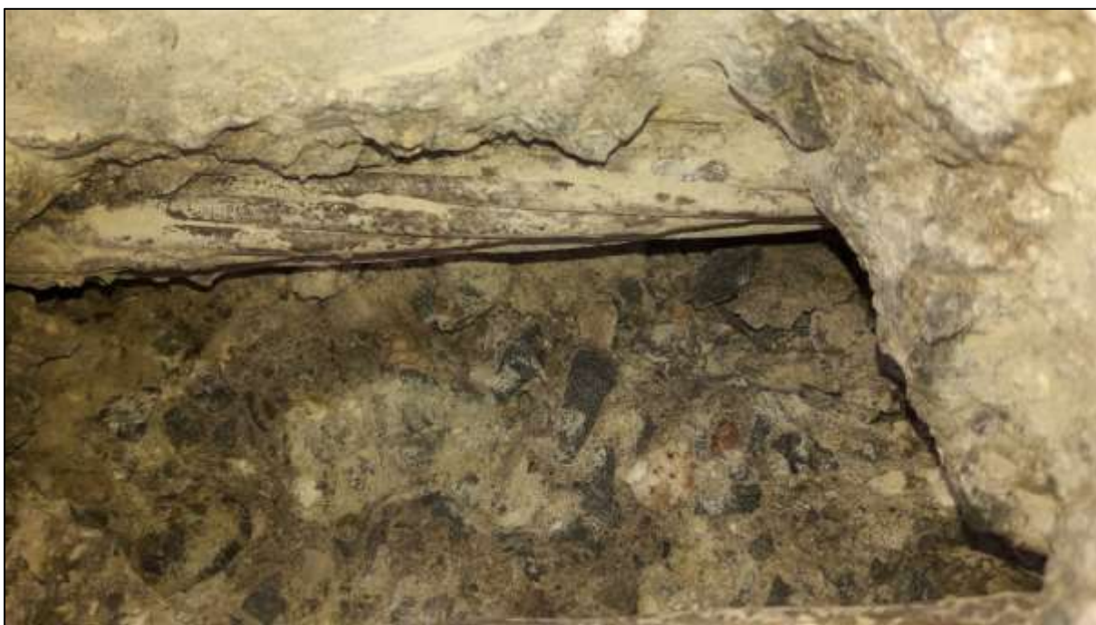
Foto 72: Pohled na korozní stav kabelů L 3, po zvýraznění kontrastu navlhčením povrchu
