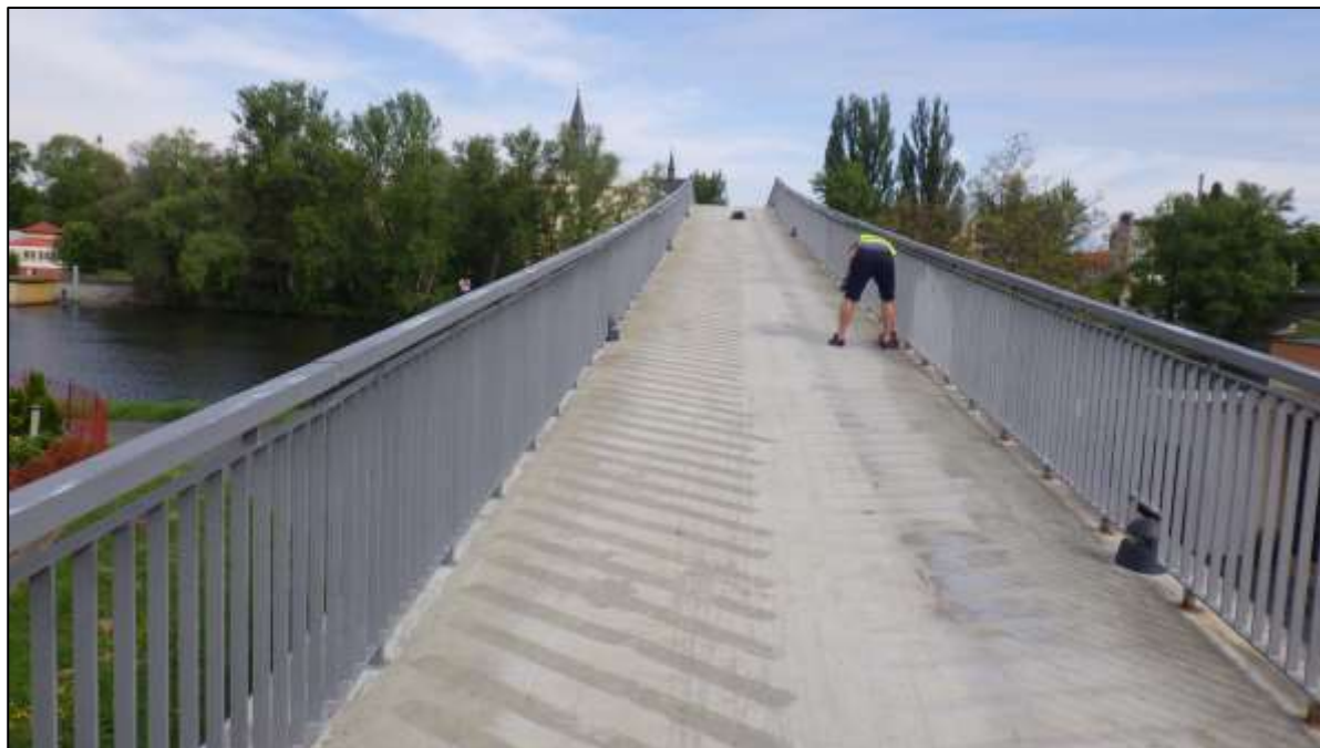
Foto 4: Pohled na typicky degradovanou povrchovou stěrku pole 3-4, vlevo zdrsněné pruhy na nejstrmější části lávky, pro bezpečnější zimní provoz chodců, řada lokálních oprav v ploše, obnažená – mechanicky nechráněná izolační membrána ve velkých plochách vpravo
