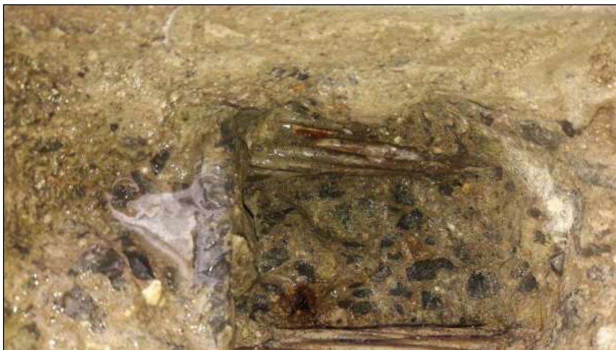
Foto 103: Bližší pohled na korozní stav odkrytých předpínacích lan kabelu P 1 a 2, nesouvislá povrchová korozí, ojediněle propagace korozí ze štěrbiny mezi patentovými dráty
