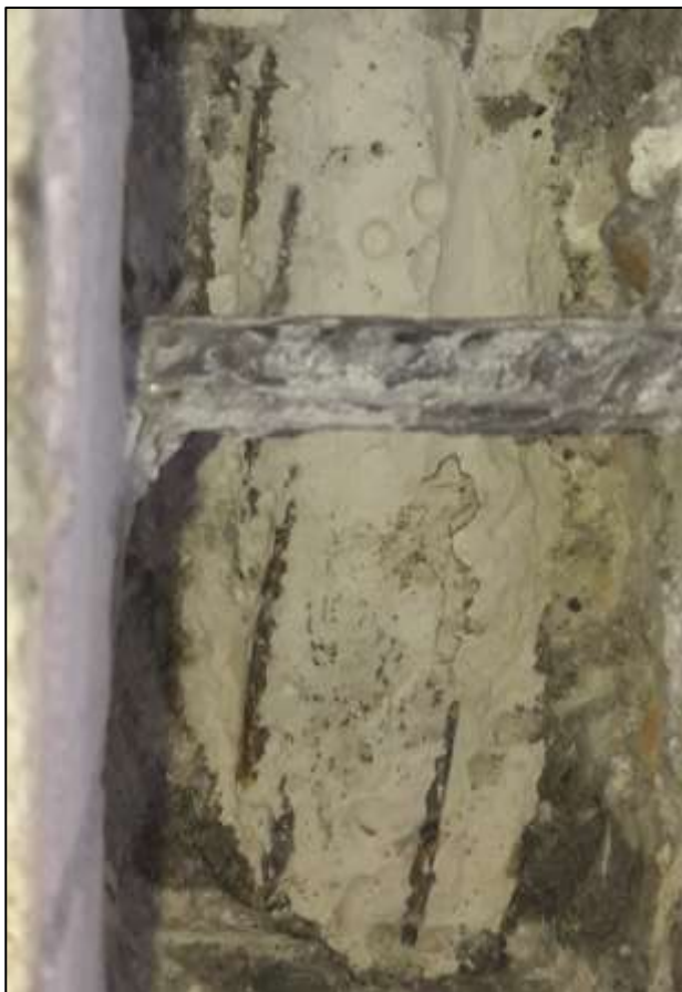
Foto 46: Pohled z blízka na povrch předpínací výztuže s drobnými bodovými náznaky počínající povrchové koroze
