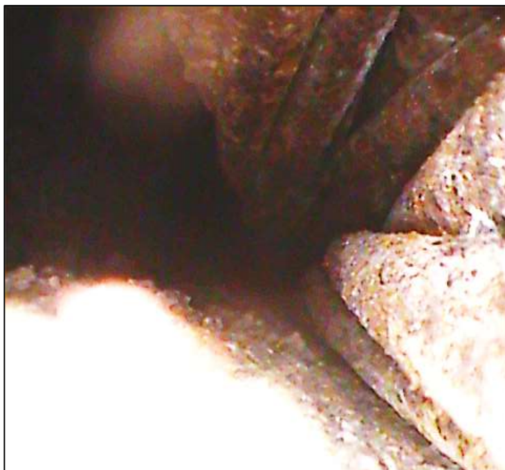
Foto 86: Detailní pohled na lana kabelu P2, patrná koroze patentových drátů, směr spára 1, délka dutiny cca 50 cm od spodní sondy
