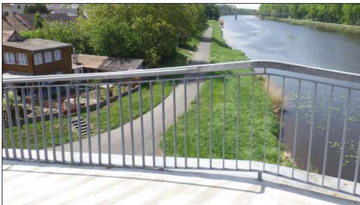
Foto 18: Deformace zábradlí – levá strana, sedlo nad pilířem 2, značně proměnná výška spodní pásnice výplně nad mostovkou
