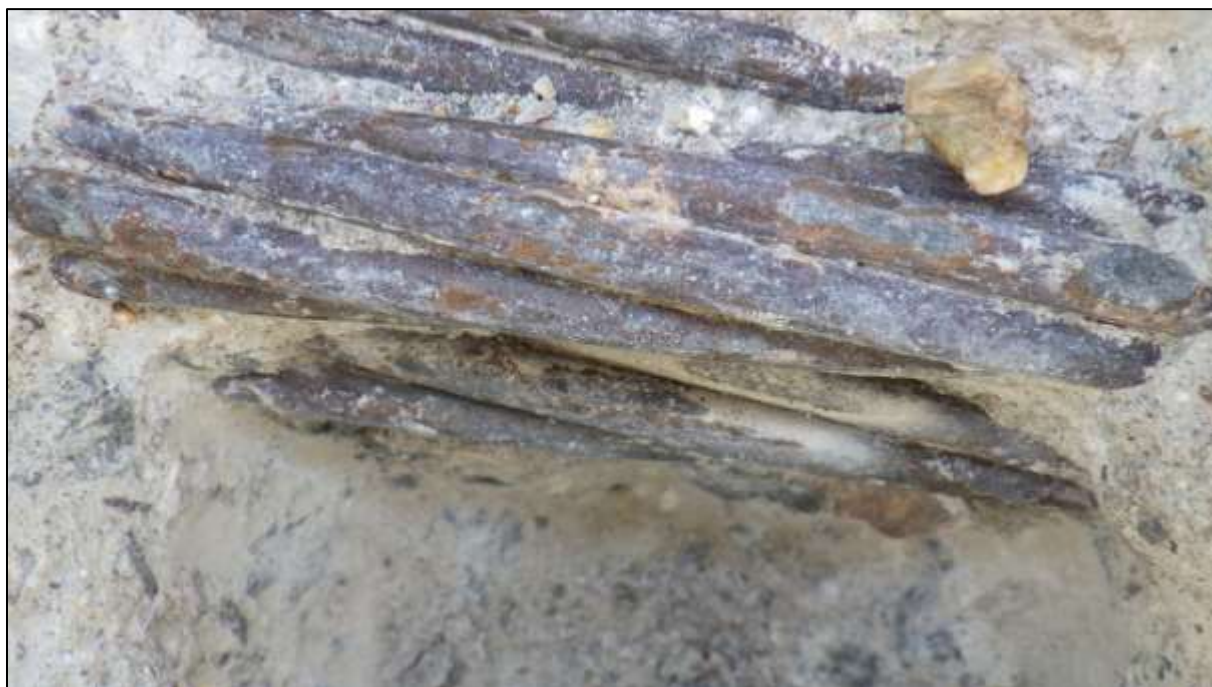
Foto 130: Bližší pohled na korozní stav odkrytých předpínacích lan kabelu L 2, nesouvislá povrchová koroze, místy propagace koroze ze štěrbiny mezi patentovými dráty
