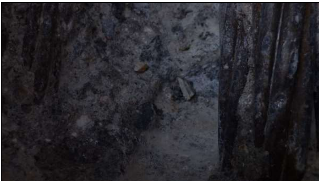
Foto 128: Pohled do téže sondy, vpravo kabel P2, nesouvislá povrchová koroze, místy propagace koroze ze štěrbiny mezi patentovými dráty
