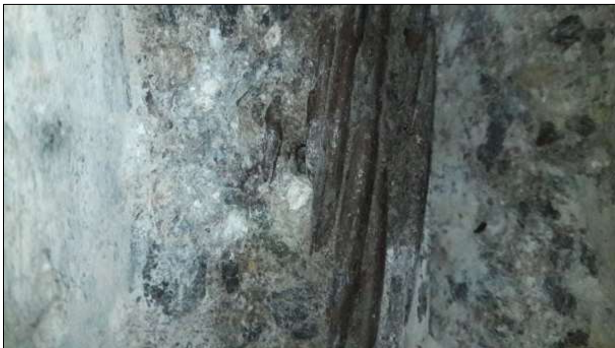
Foto 110: Bližší pohled na korozní stav odkrytých předpínacích lan kabelu L3, pouze nepatrná nesouvislá povrchová koroze
