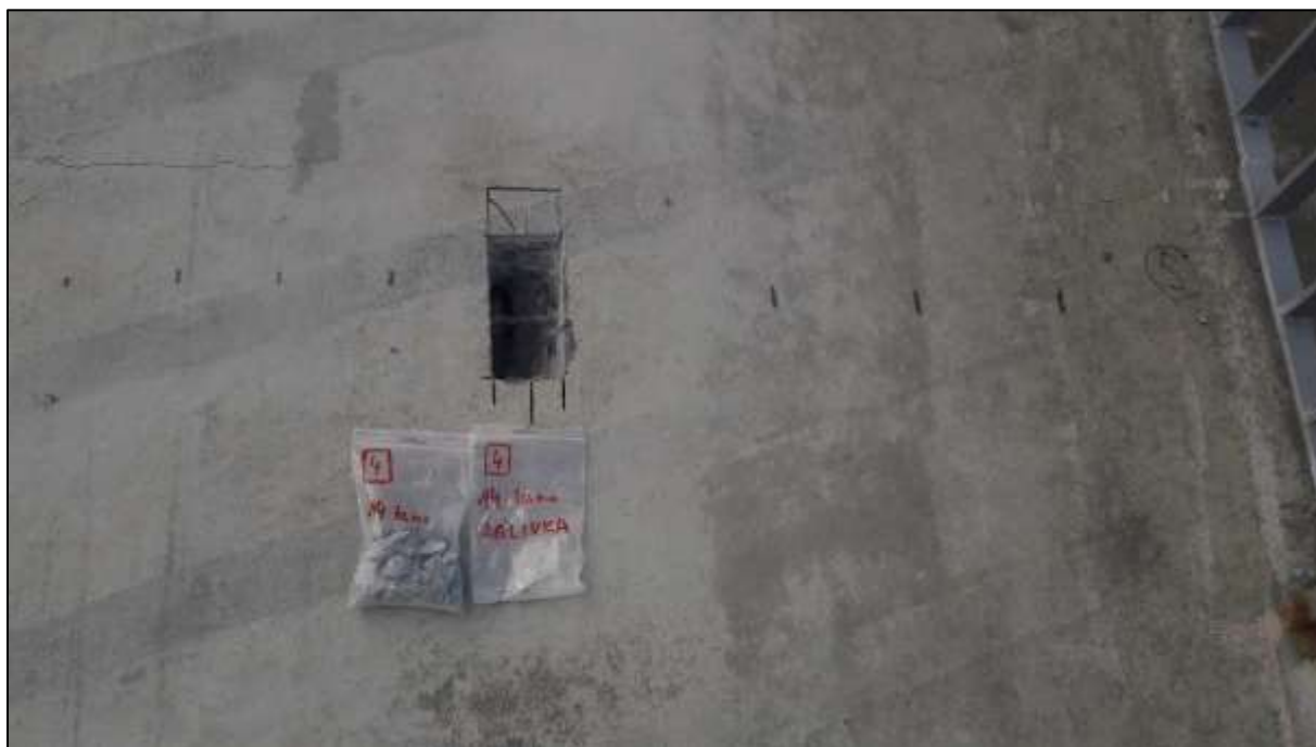
Foto 48: Semidestruktivní sonda ke kabelu „systému B“ v kanálku, prefabrikát 4-5, kanálek 14, odebraný vzorek betonu a injektáže
