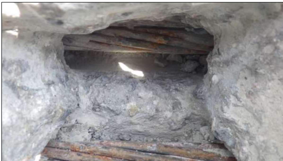
Foto 63: Pohled do sousední sondy, na kabely v nezainjektovaných kanálcích 10 a 11, viditelné stopy koroze na povrchu patentových drátů předpínacích lan
