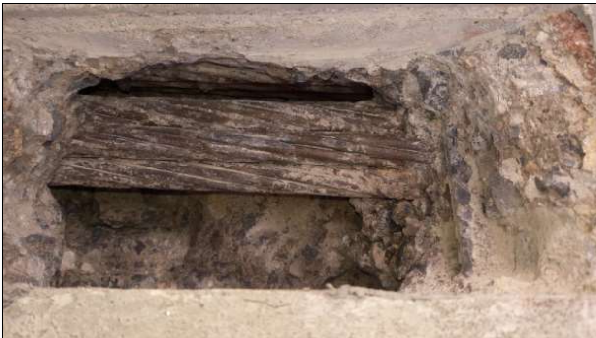
Foto 71: Pohled na korozní stav kabelů L 2, po zvýraznění kontrastu navlhčením povrchu
