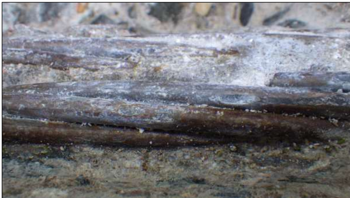
Foto 125: Bližší pohled na korozní stav odkrytých předpínacích lan kabelu L 2, nesouvislá povrchová koroze, místy počínající důlky a propagace koroze ze štěrbiny mezi patentovými dráty
