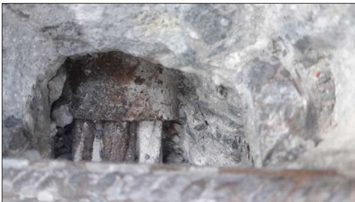
Foto 57: Obdobný korozní stav kabelu 7 na druhém konci sondy, s viditelně stejně korozně napadenou ocelovou trubičkou – průchodkou styčné spáry panelů, lokální koroze na povrchu měkké žebírkové výztuže nad kabelem
