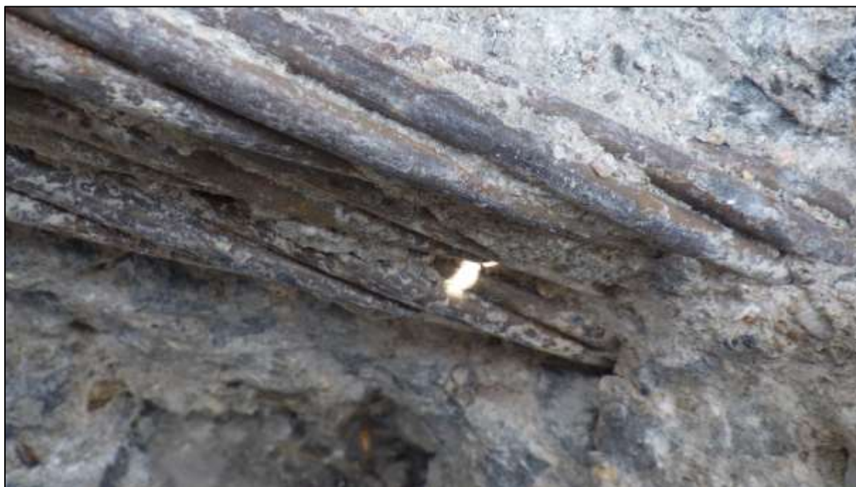
Foto 115: Bližší boční pohled na korozní stav odkrytých předpínacích lan kabelu L 2-3, nesouvislá povrchová koroze, lokálně zřetelná propagace koroze ze štěrby mezi patentovými dráty
