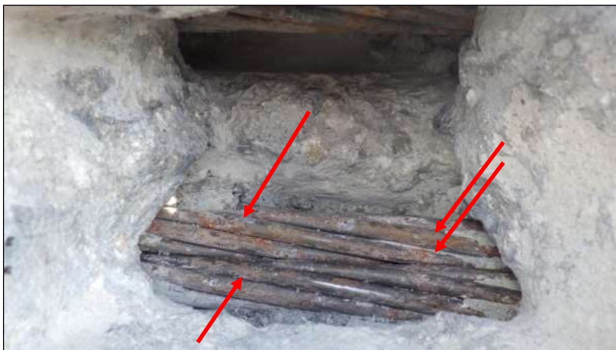
Foto 64: Bližší pohled na zasažení povrchu patentových drátů předpínacích lan kabelu 10 lokální důlkovou korozi se zřetelným oslabením jejich profilu
