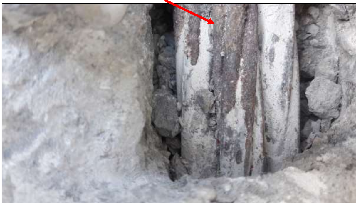
Foto 56: Detail poměrně dobře zainjektovaného kanálku s kabelem 7, po sejmutí části injektážní hmoty zřetelně drsný povrchu patentových drátů, zasažených rozvinutou povrchovou korozí, s odlupující se tmavou vrstvičkou - patrně již magnetitu
