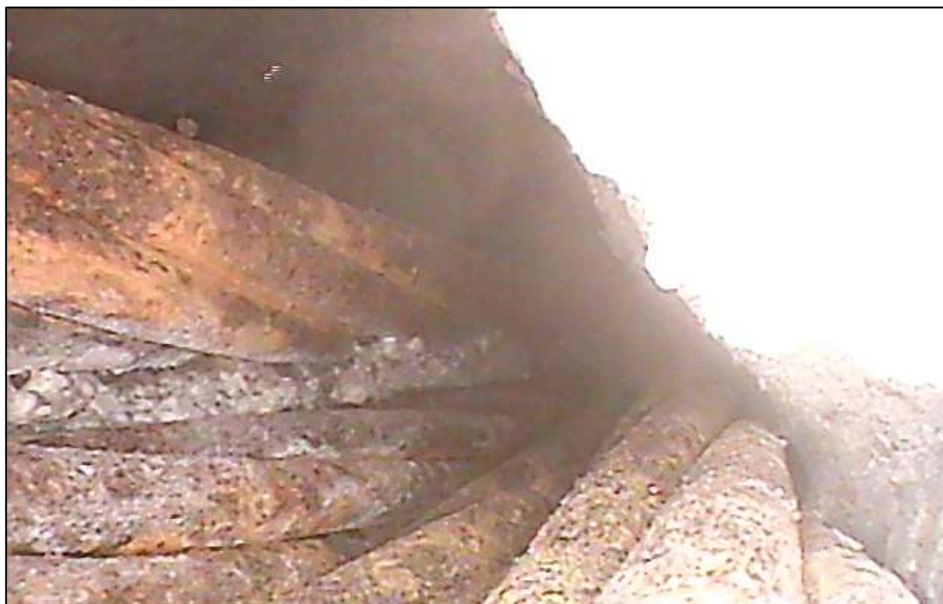
Foto 84: Detailní pohled na lana kabelu P2, patrná koroze patentových drátů, směr spára 3, stav v úrovni horní hrany sondy
