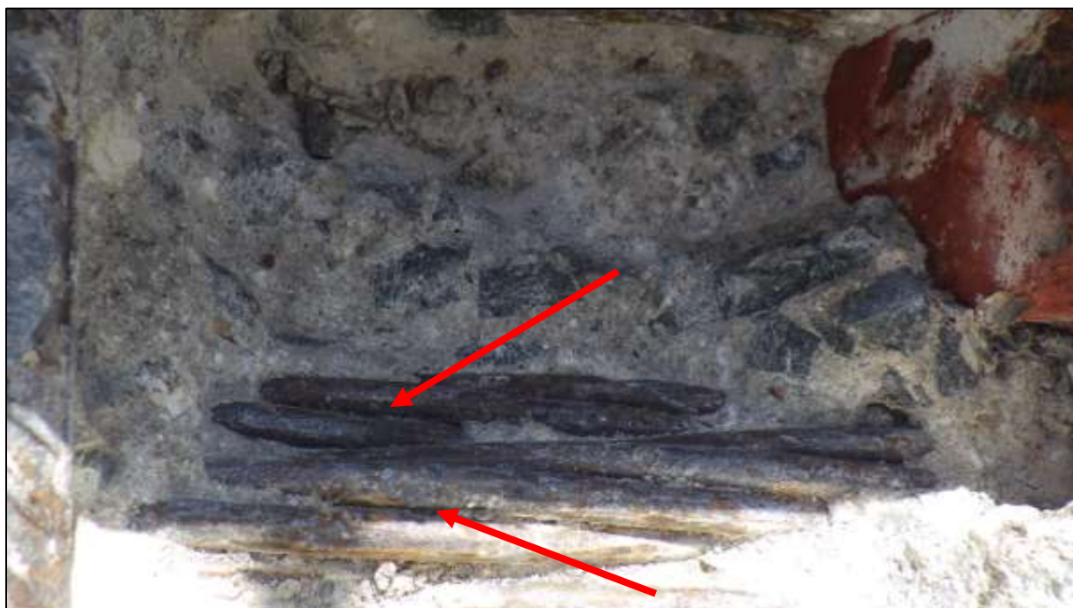
Foto 136: Bližší pohled na korozní stav odkrytých předpínacích lan kabelu L 1, nesouvislá slabá povrchová koroze, místy propagace koroze ze štěrbin mezi patentovými dráty (viditelné dutiny mezi dráty)
