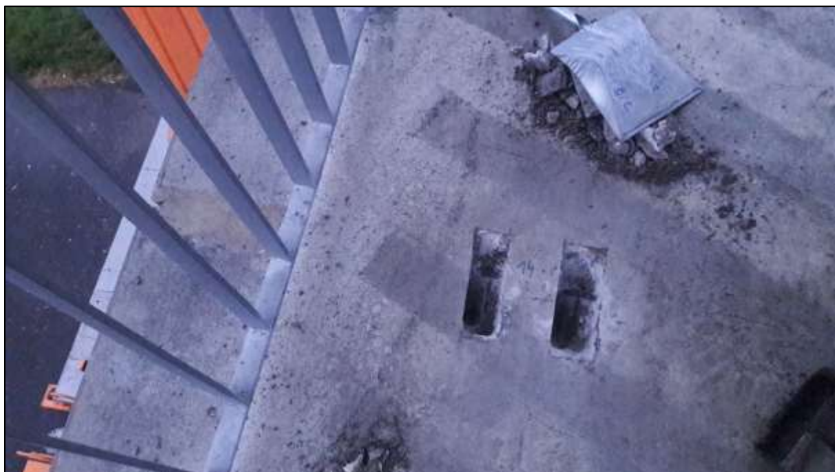
Foto 108: Pohled na otevřenou semidestruktivní sondu ke kabelům „systému A“ v levé rýze, spára 14, kabely L 1-2 a 2-3
