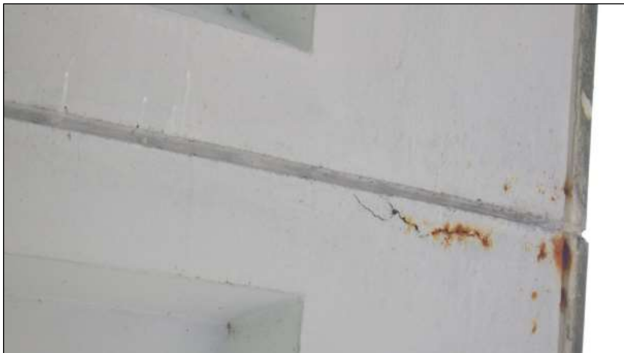
Foto 21: Pohled na rozvinuté projevy koroze výztuže a výluhy na podhledu pole 1-2, u styčné spáry vlevo
