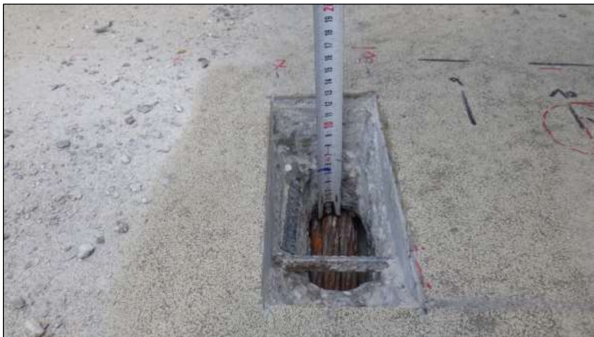
Foto 61: Ilustrace velikosti provedené sondy, resp. hloubky vedení kabelu 8
