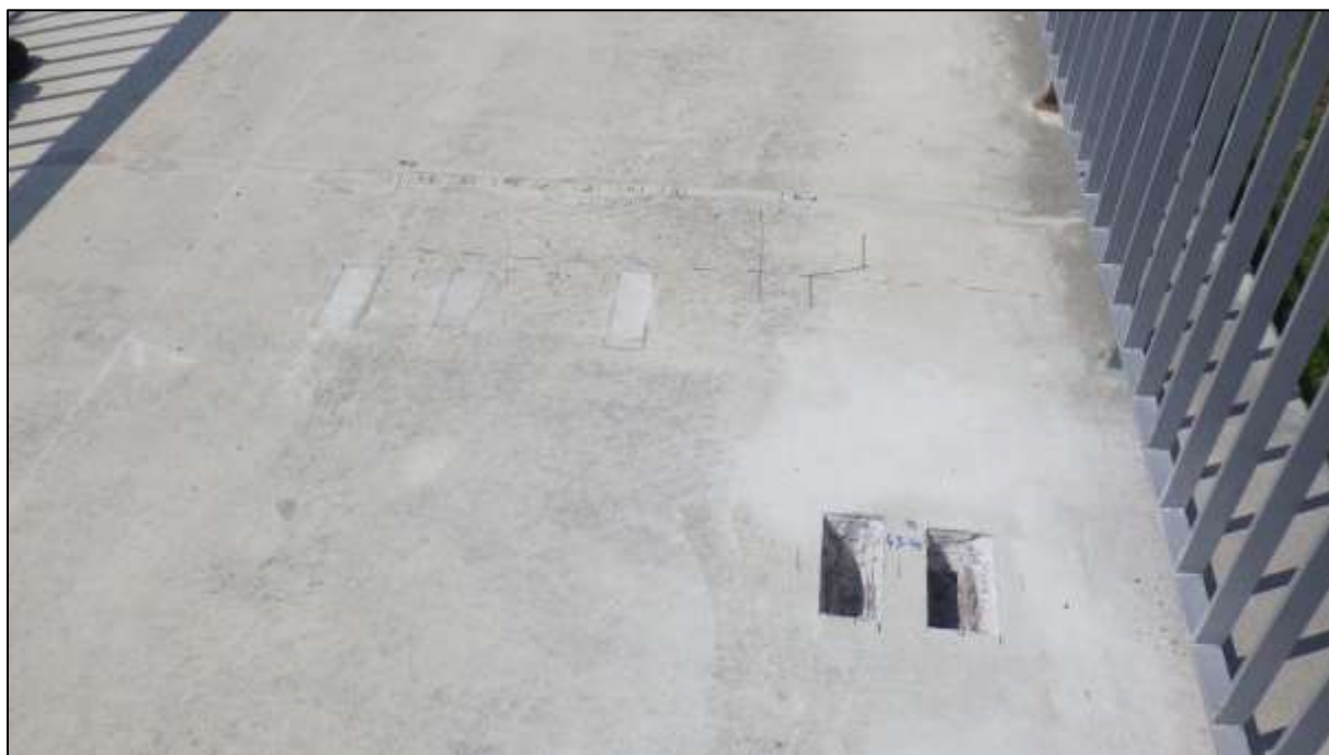
Foto 113: Pohled na otevřenou semidestruktivní sondu ke kabelům „systému A“ v pravé rýze, prefabrikát 43-44, kabely P 1-2 a 2-3
