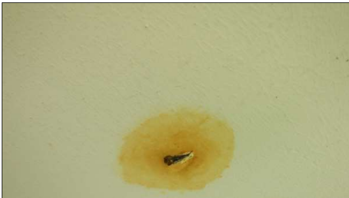
Foto 30: Lokální koroze betónářské výztuže vlevo na podhledu prefabrikátu 67-68, pod rýhou lan „systému A“
