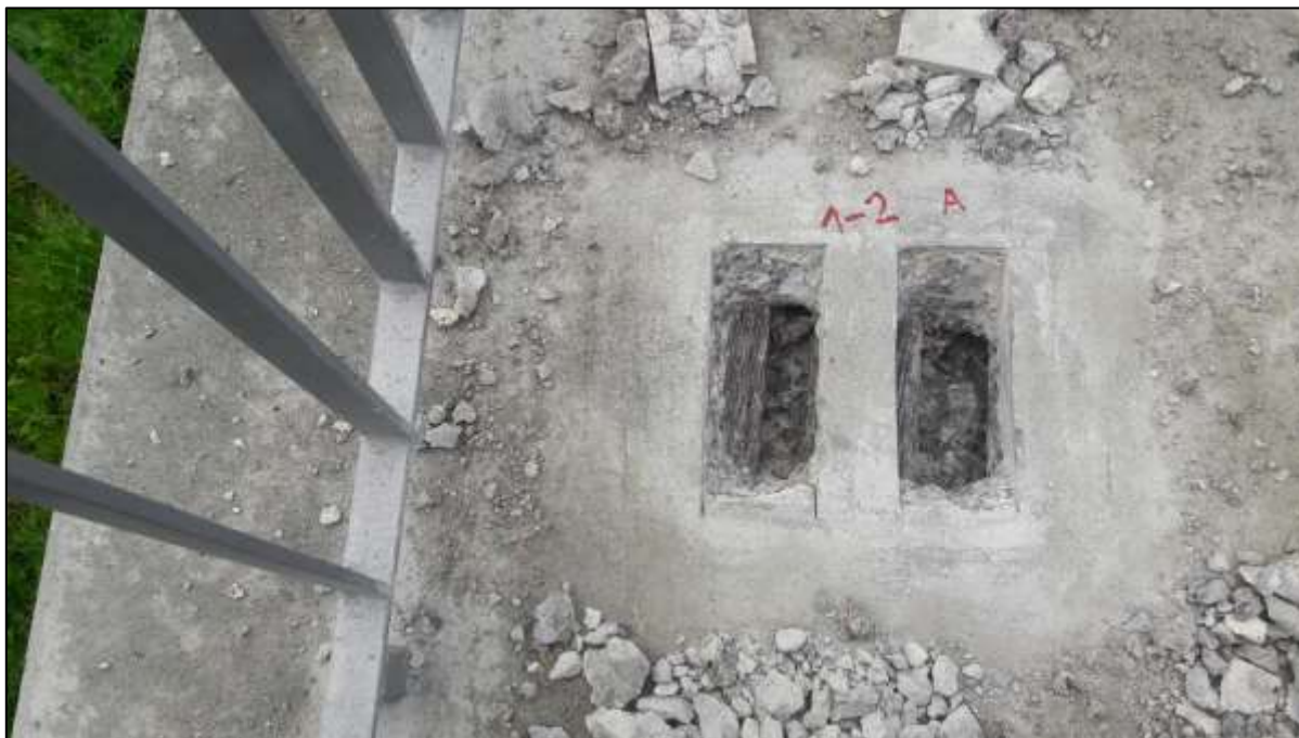
Foto 67: Pohled na otevřené semidestruktivní sondy ke kabelům „systému A“ v levé rýze, prefabrikát 1-2, mezi kabely L 1-2, 2-3
