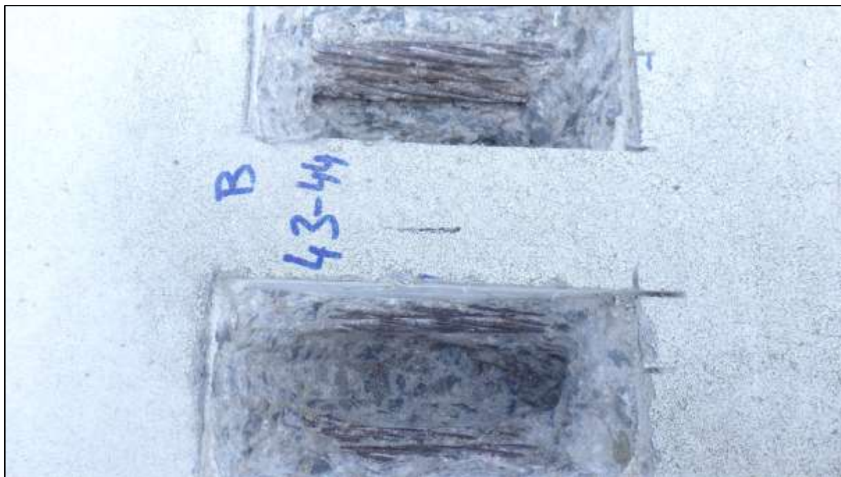
Foto 114: Blížeší pohled na korozní stav odkrytých předpínacích lan kabelu L1-2 a 3, nesouvislá povrchová koroze, místy propagace koroze ze štěrbin mezi patentovými dráty
