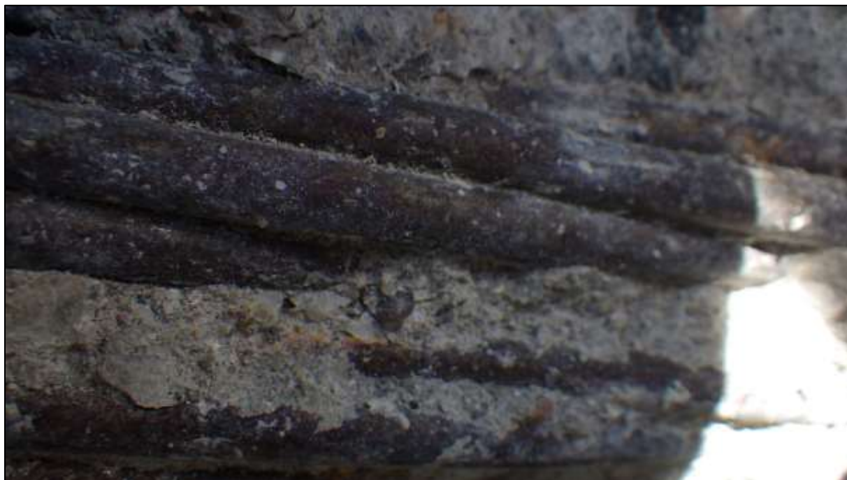
Foto 143: Bližší pohled na korozní stav odkrytých předpínacích lan kabelu L 2, nesouvislá povrchová koroze, místy propagace koroze ze štěrbin mezi patentovými dráty
