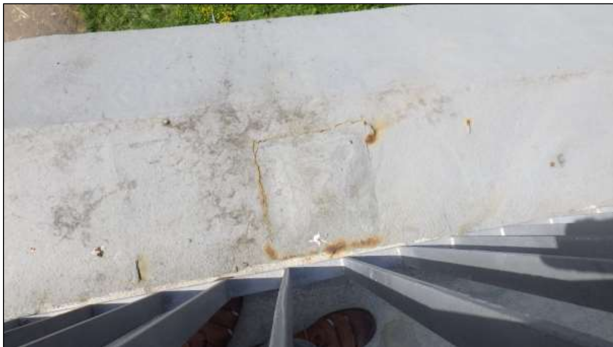
Foto 19: Sedlo vpravo nad pilířem č.2, koroze dodatečného překrytí místa vně zábradlí, snad otvoru - nejasného účelu
