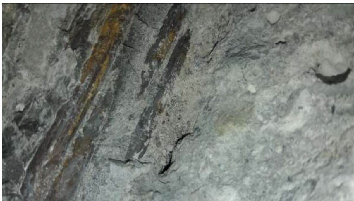
Foto 52: Detailnější pohled na charakter počínající lokální koroze na drátech kabelu 10 po jeho odstranění další části injektážní hmoty z jeho povrchu
