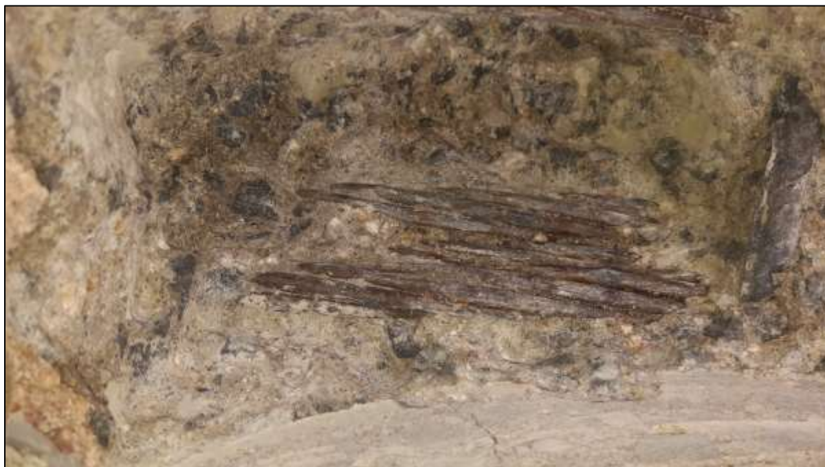
Foto 95: Bližší pohled na korozní stav odkrytých předpínacích lan kabelu P 3
