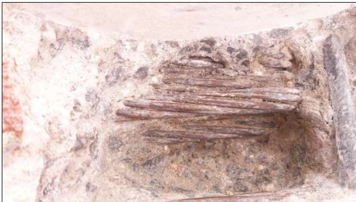
Foto 98: Bližší pohled na korozní stav odkrytých předpínacích lan kabelu L 1, nesouvislá povrchová koroze, místy propagace koroze ze štěrbin mezi patentovými dráty
