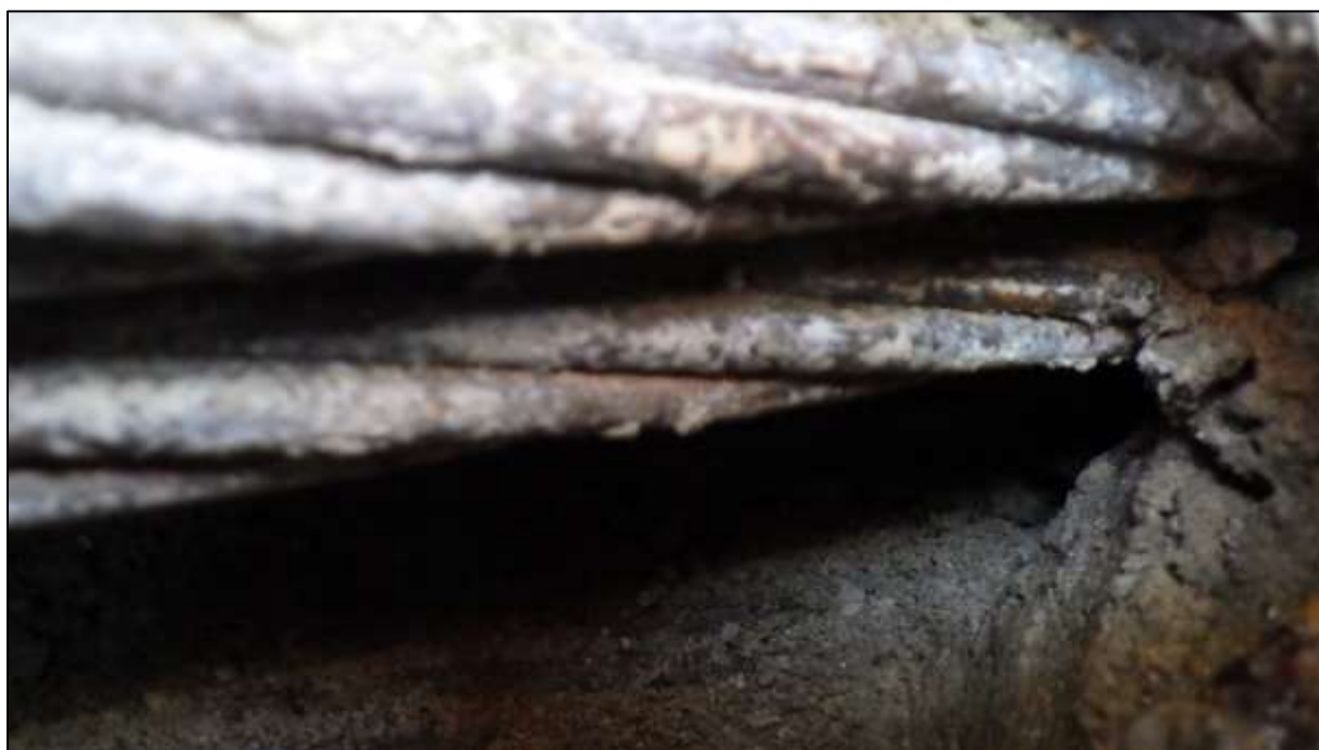
Foto 81: Boční pohled do dutiny mezi kabely P2 a 4 s viditelnou korozi spodního lana kabelu P2 a nehybnou vrstvou betonu výplně
