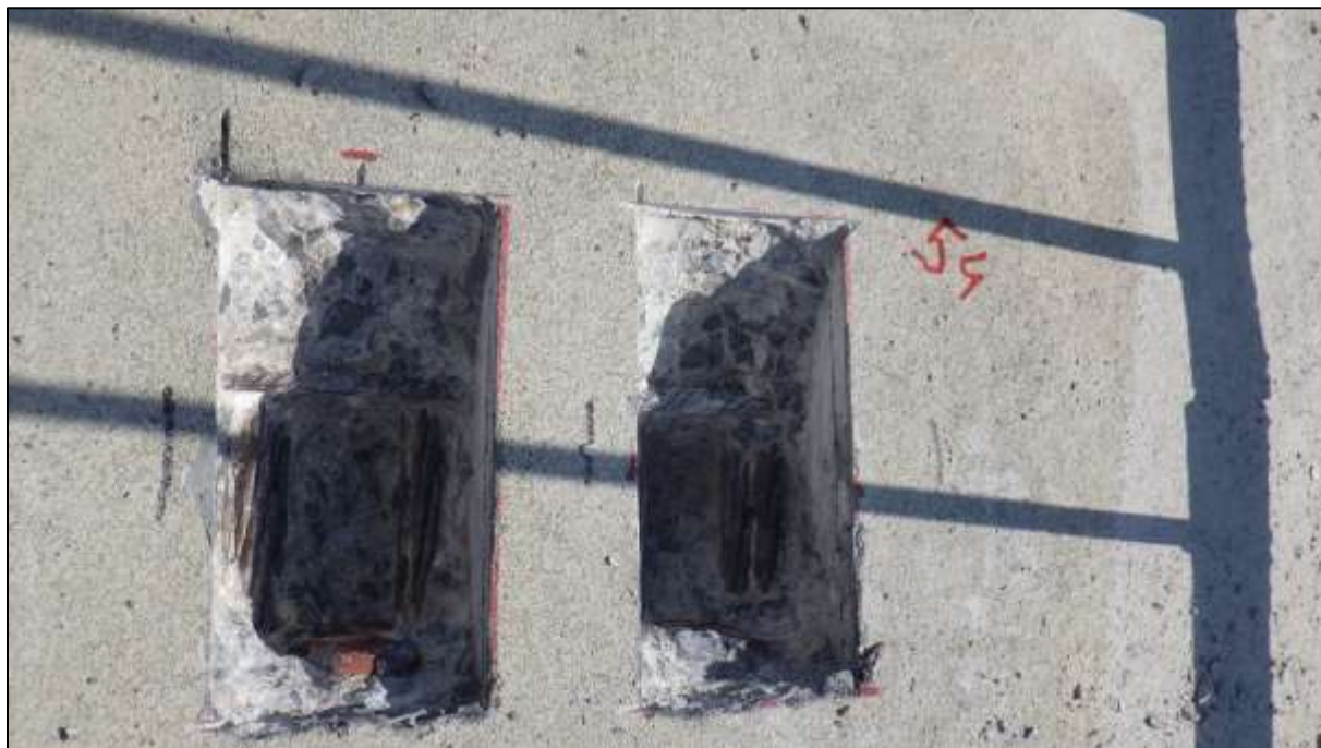
Foto 135: Pohled na otevřenou semidestruktivní sondu ke kabelům „systému A“ v levé rýze, spára 54, kabely L 1-2, 3
