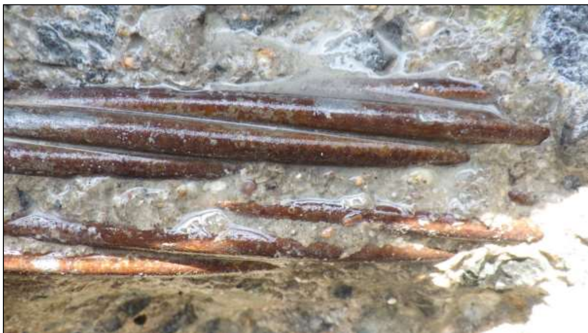
Foto 140: Bližší pohled na korozní stav odkrytých předpínacích lan kabelu L 3, kontrastní vzhled po navlhčení, slabá takřka souvislá povrchová koroze,
