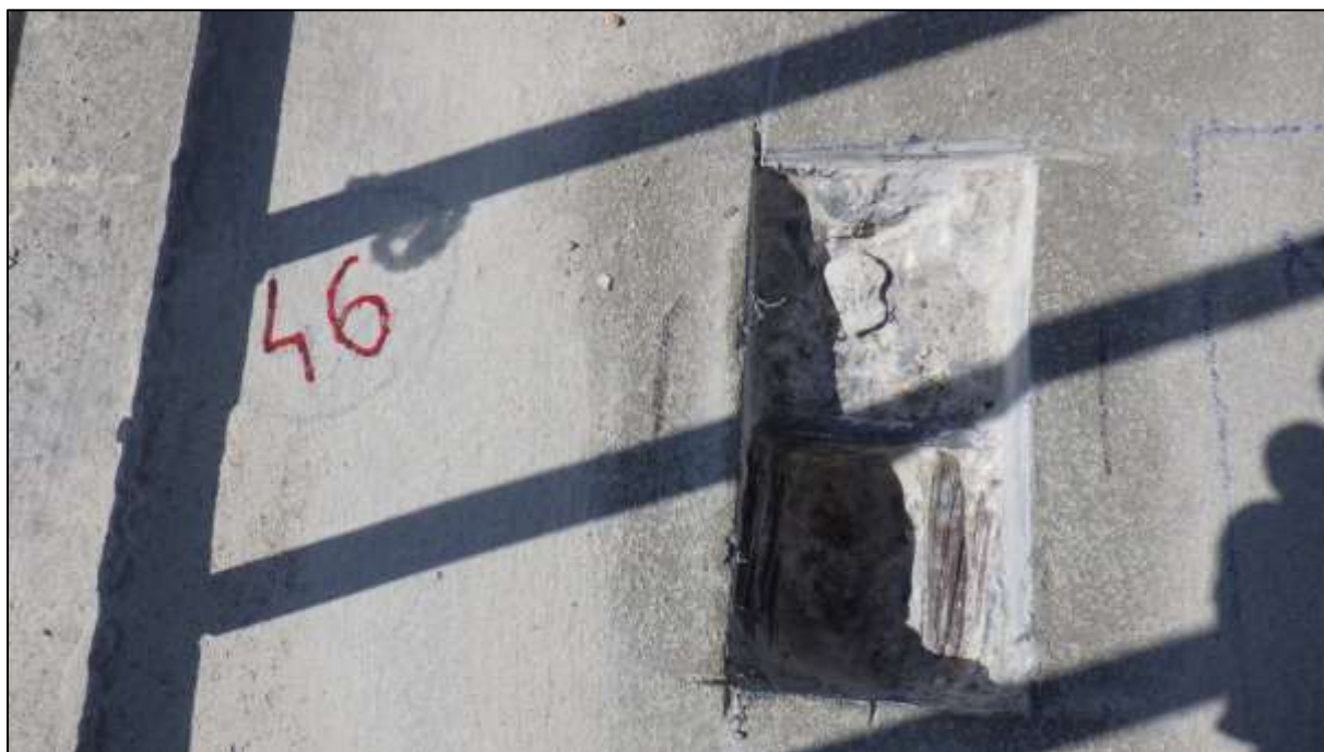
Foto 121: Pohled na otevřenou semidestruktivní sondu ke kabelům „systému A“ v levé rýze, spára 46, kabely L 1-2
