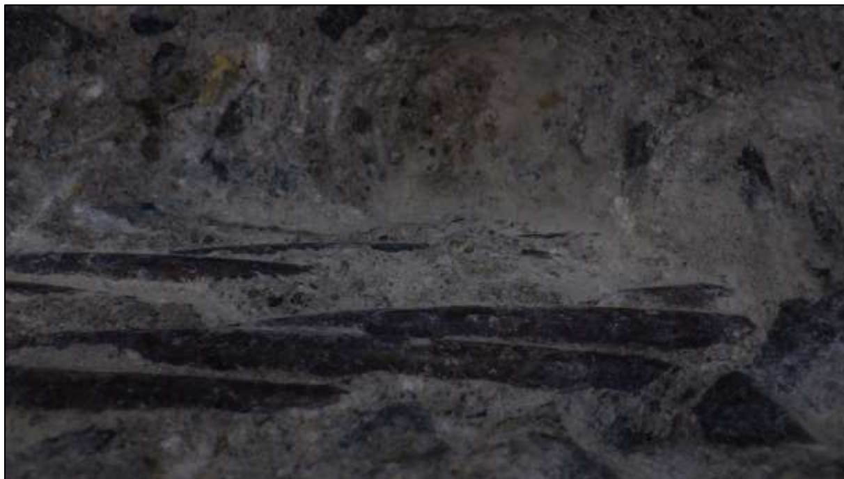
Foto 145: Bližší pohled na korozní stav odkrytých předpínacích lan kabelu L 3, nevýrazná povrchová koroze, místy tendence ke vzniku důlků
