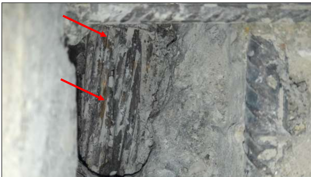
Foto 49: Pohled na kabel 14 po odebrání vzorků injektáže, velmi malé náznaky bodové koroze na povrchu předpínacího lana, viditelný rozvoj koroze ve štěrbině mezi jeho patentovými dráty
