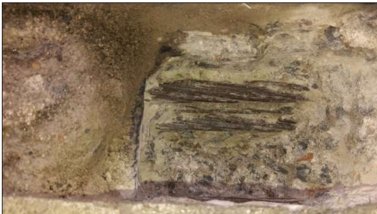
Foto 102: Bližší pohled na korozní stav odkrytých předpínacích lan kabelu P 3, nesouvislá povrchová koroze, ojediněle propagace koroze ze štěrbiny mezi patentovými dráty
