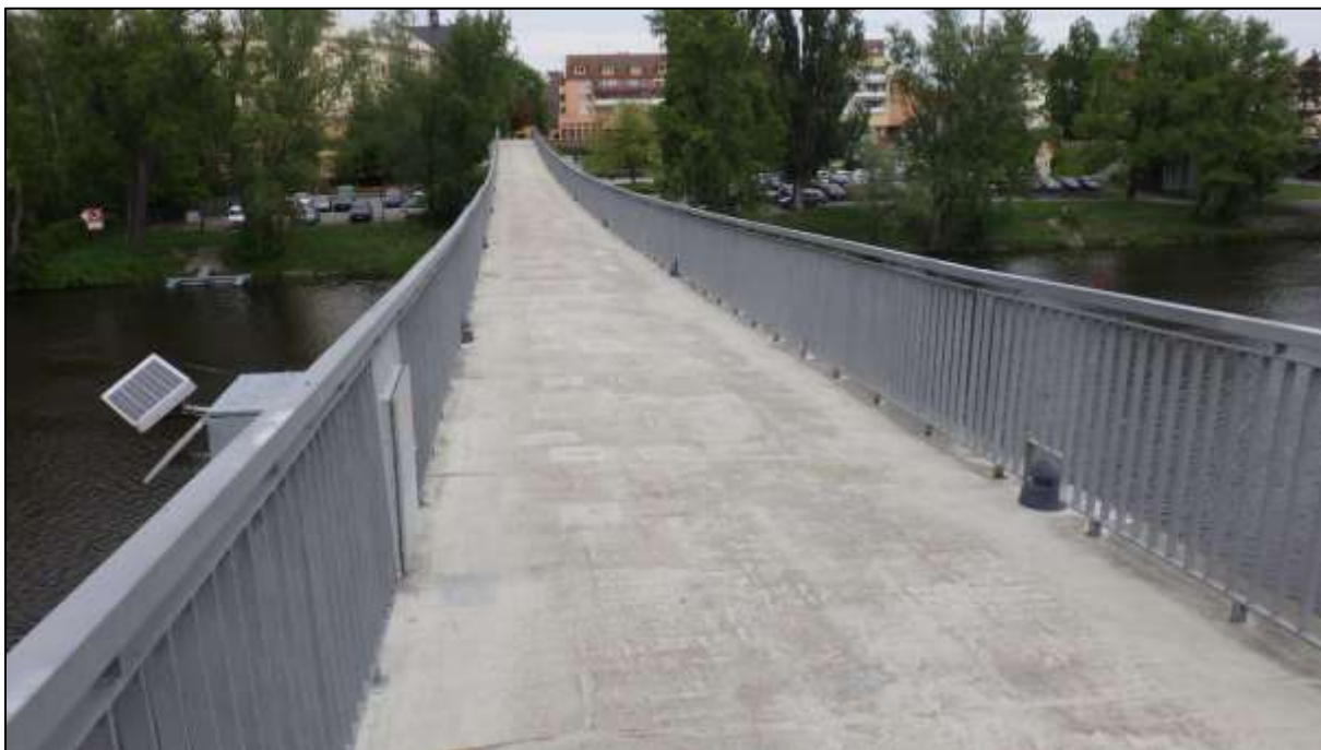
Foto 16: Pohled střední pole lávky směrem k městu, vlevo limnigraf, viditelné množství oprav stěrky a deformace zábradlí na obou stranách
