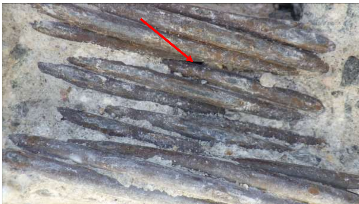
Foto 133: Bližší pohled na korozní stav odkrytých předpínacích lan kabelu L 3, nesouvislá slabá povrchová koroze, místy propagace koroze ze štěrbin mezi patentovými dráty (viditelné dutiny mezi lany)
