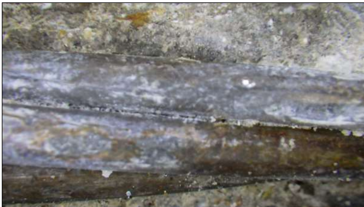
Foto 126: Detail koroze bočního drátu spodního lana, stav L1 je obdobný
