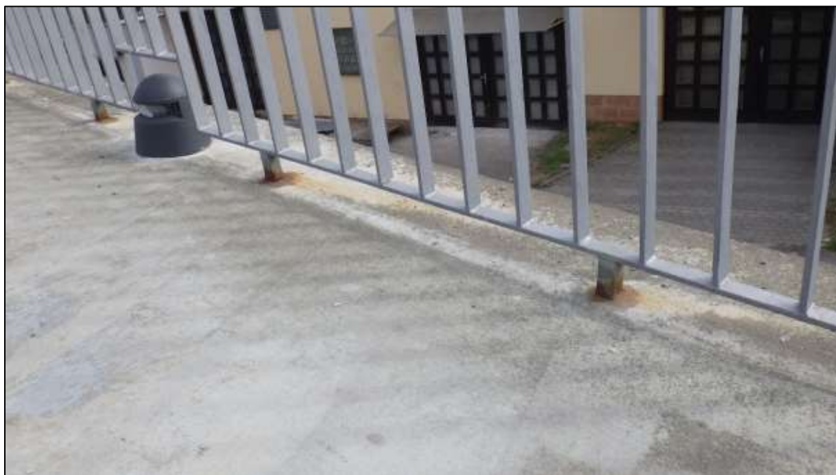
Foto 5: Pohled na typicky rozvinutý stav koroze sloupků ocelového zábradlí, černé kupole bočního osvětlení – instalace z roku 2006
