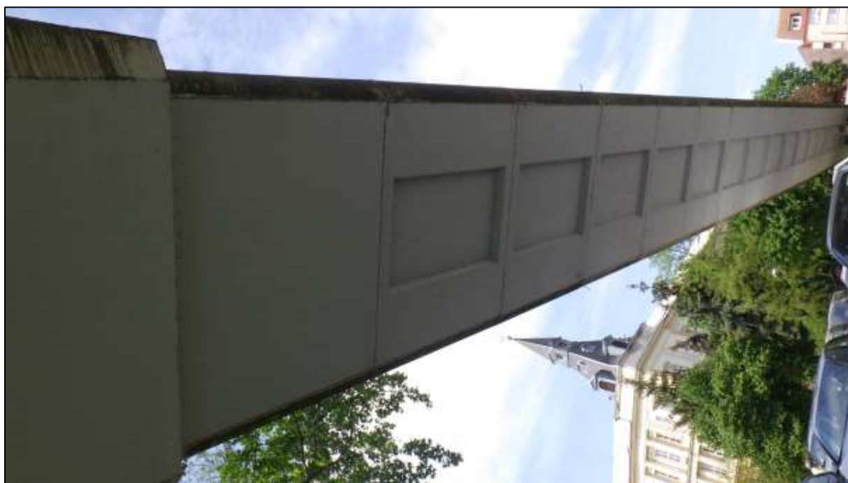
Foto 24: Pohled na podhled posledního pole (3-4), od spáry se sedlem (48-70) - centru, viditelné lokální průsaky s korozí výztuže na krajích v místech příčných spár, visící vypadávající tmelové výplně na podhledu
