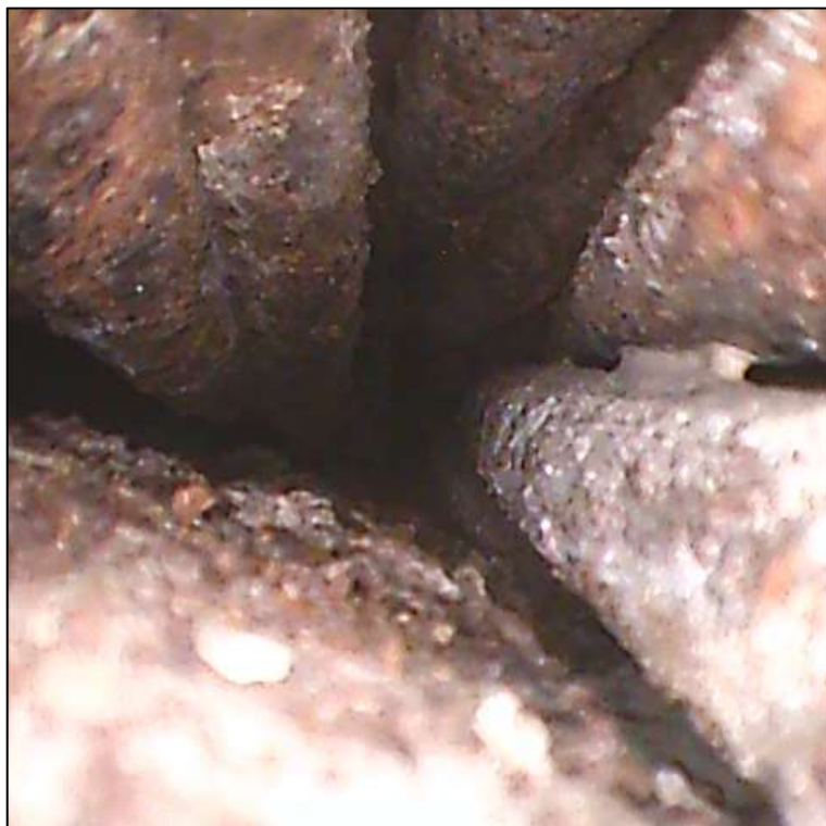
Foto 87: Detailní pohled lana kabelu P2, patrná koroze patentových drátů, směr spára 1, délka dutiny cca 40 cm od spodní sondy
