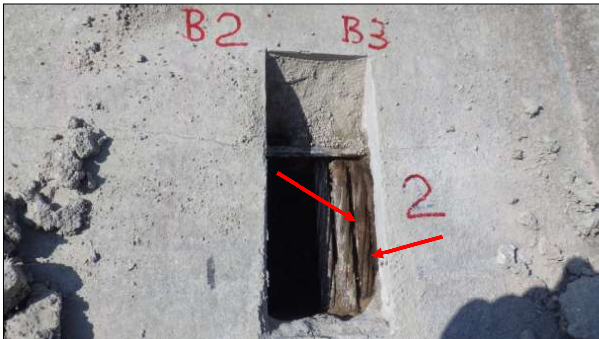
Foto 77: Pohled do sondy na kabel P3 po odstranění volných vrstev korozních zplodin z horního předpínacího lana – výrazné oslabení drátů
