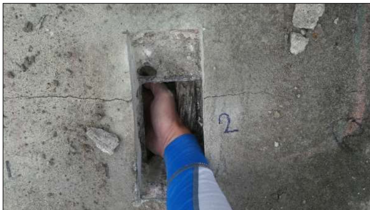
Foto 74: Do dutiny mezi vrstvy lan lze vložit ruku
