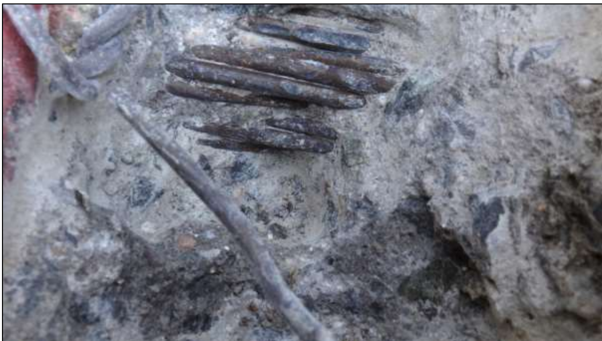
Foto 127: Pohled na otevřenou semidestruktivní sondu ke kabelům „systému A“ v pravé rýze, spára 47, kabel P 3, viz Foto 124, zde vysoká vlhkost vyrovnávací vrstvy pod stěrkou nezjištěna, povrchová koroze patentových drátů P3
