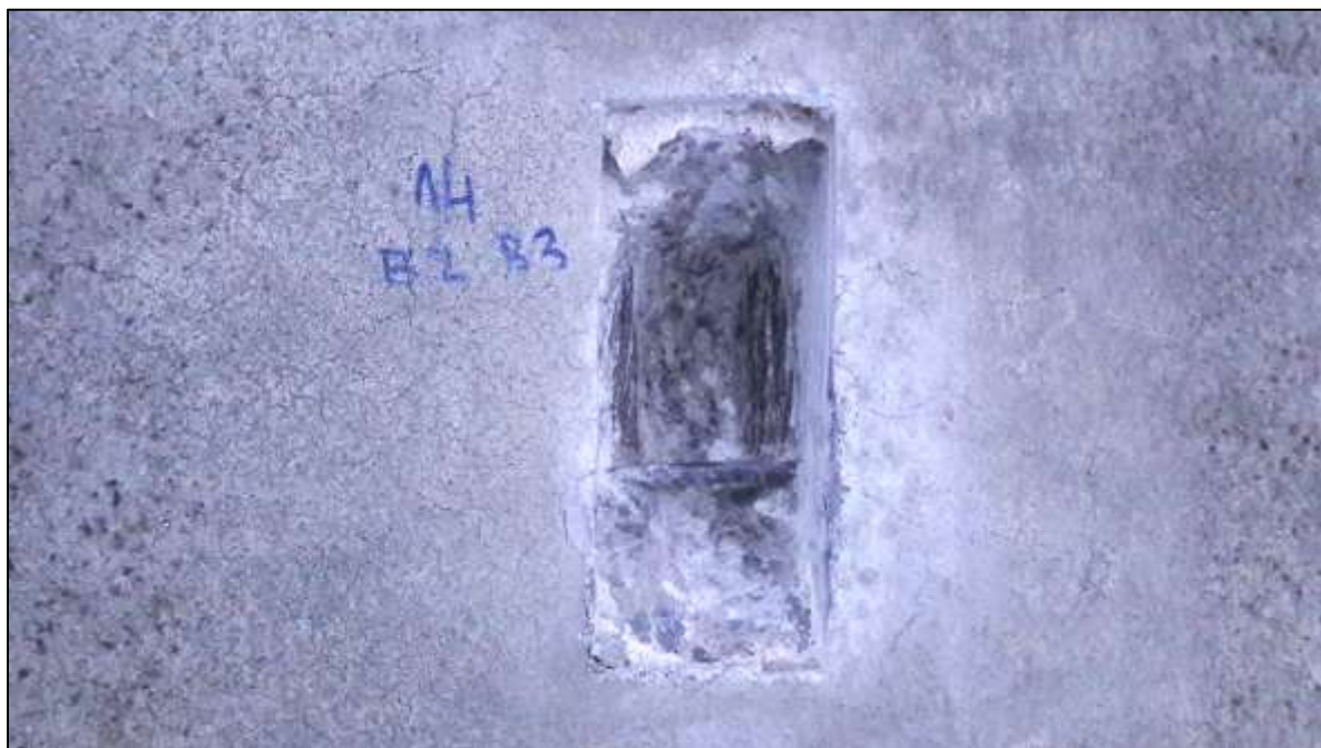
Foto 111: Pohled na otevřenou semidestruktivní sondu ke kabelům „systému A“ v pravé rýze, spára 14, kabely P 2-3
