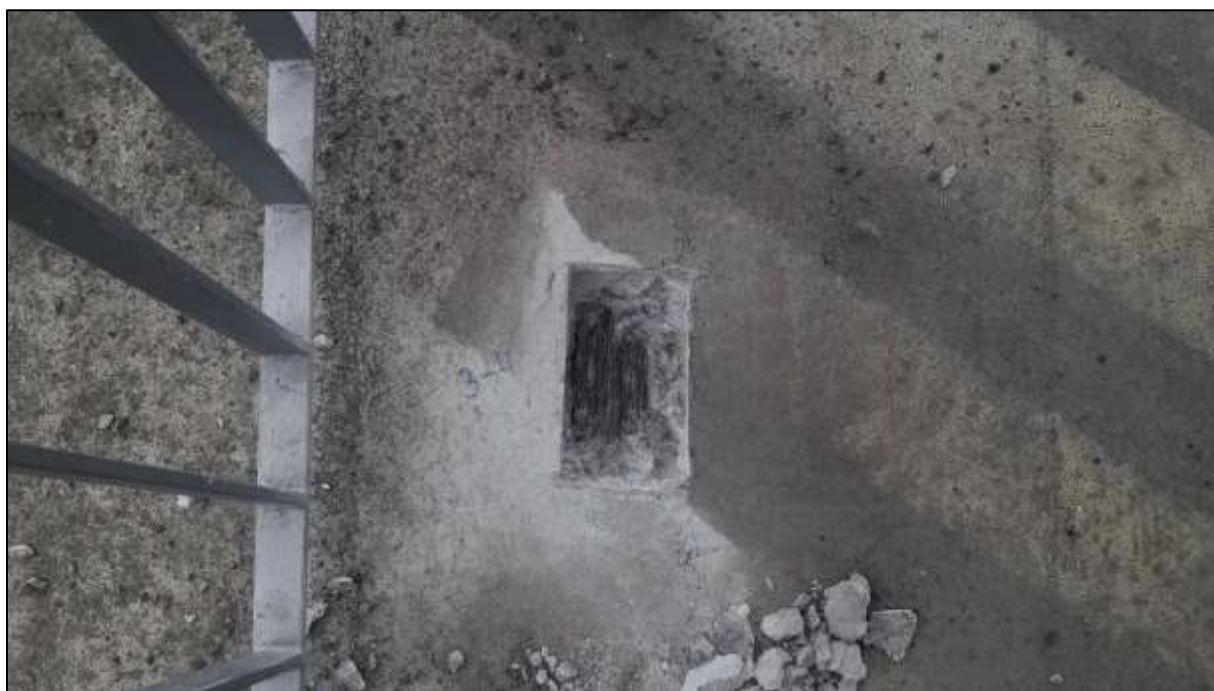
Foto 90: Pohled na otevřenou semidestruktivní sondu ke kabelům „systému A“ v levé rýze, prefabrikát 3-4, kabel L 2
