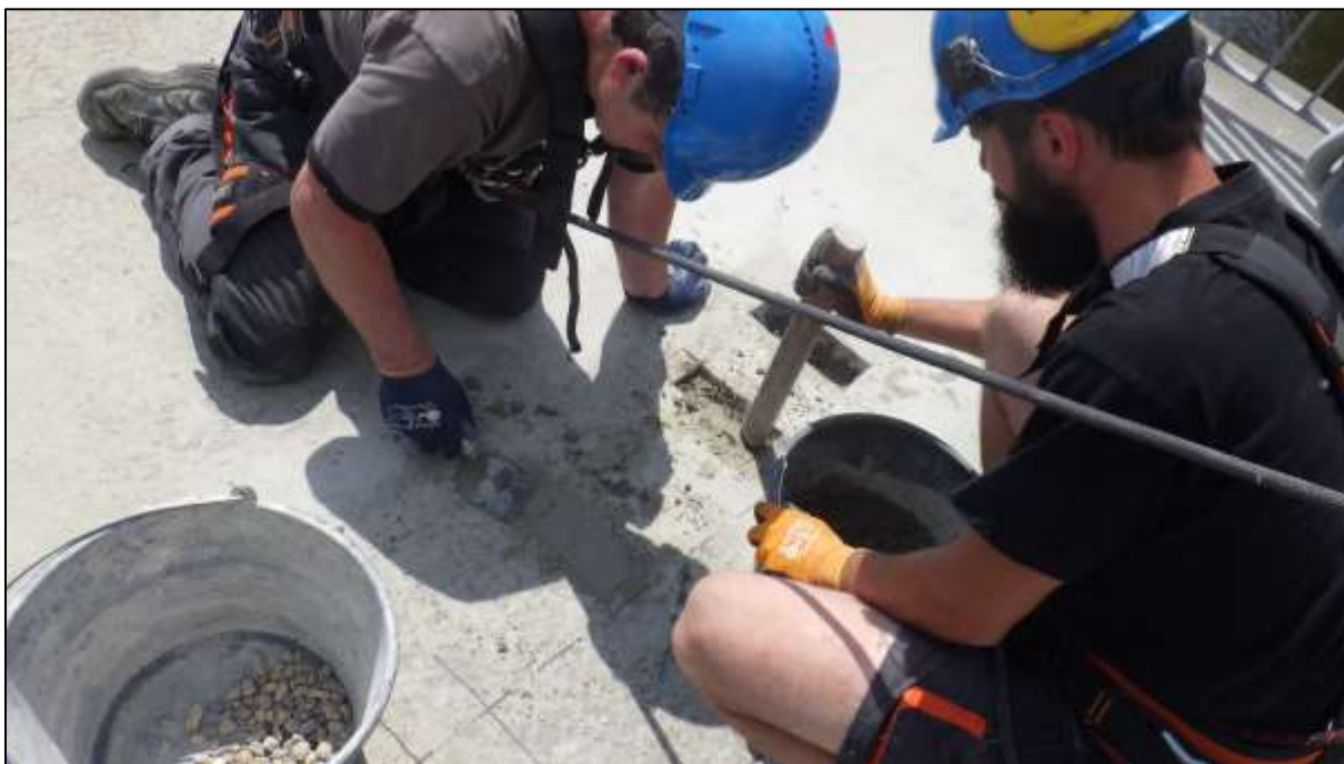
Foto 40: Provádění výplně semidestruktivních sond po prohlídce a dokumentaci stavu předpínacích lan reprofilace zavlhlou správkovou maltou
