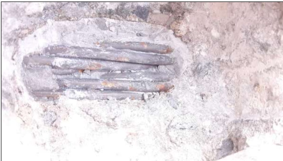
Foto 54: Detail poměrně dobře zainjektovaného kanálku s kabelem 9, po sejmutí části injektážní hmoty zřetelně viditelné počátky lokální koroze na povrchu patentových drátů
