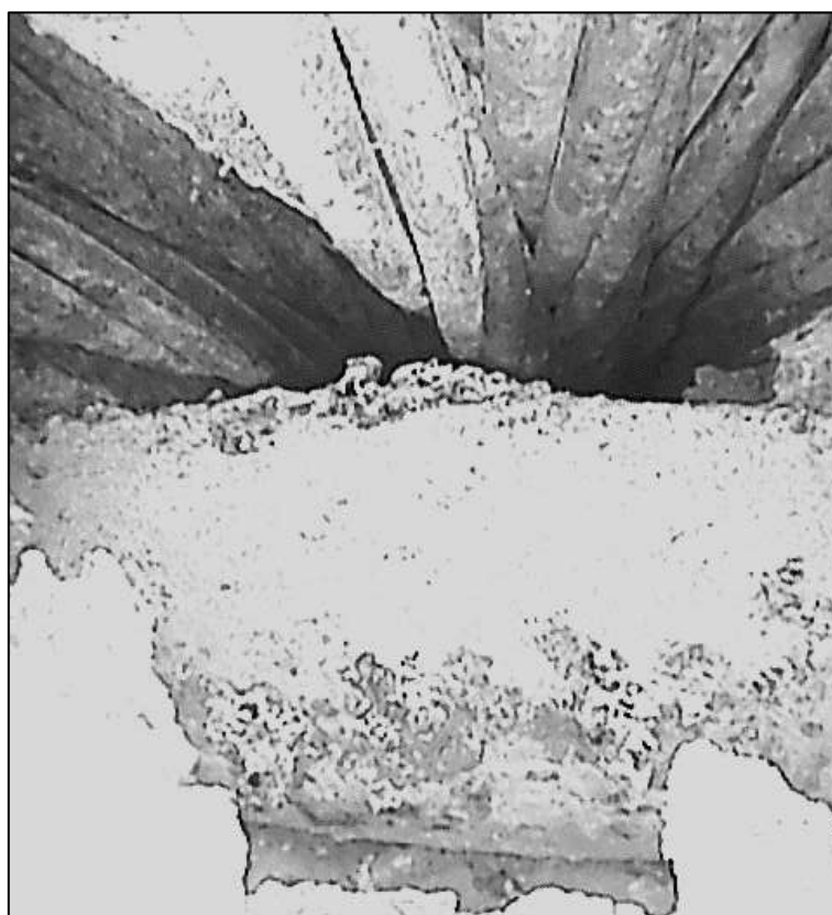
Foto 82: Pohled endoskopem zespodu na lana kabelu P2, směr spára 3, délka dutiny cca 40 cm od horní hrany sondy
