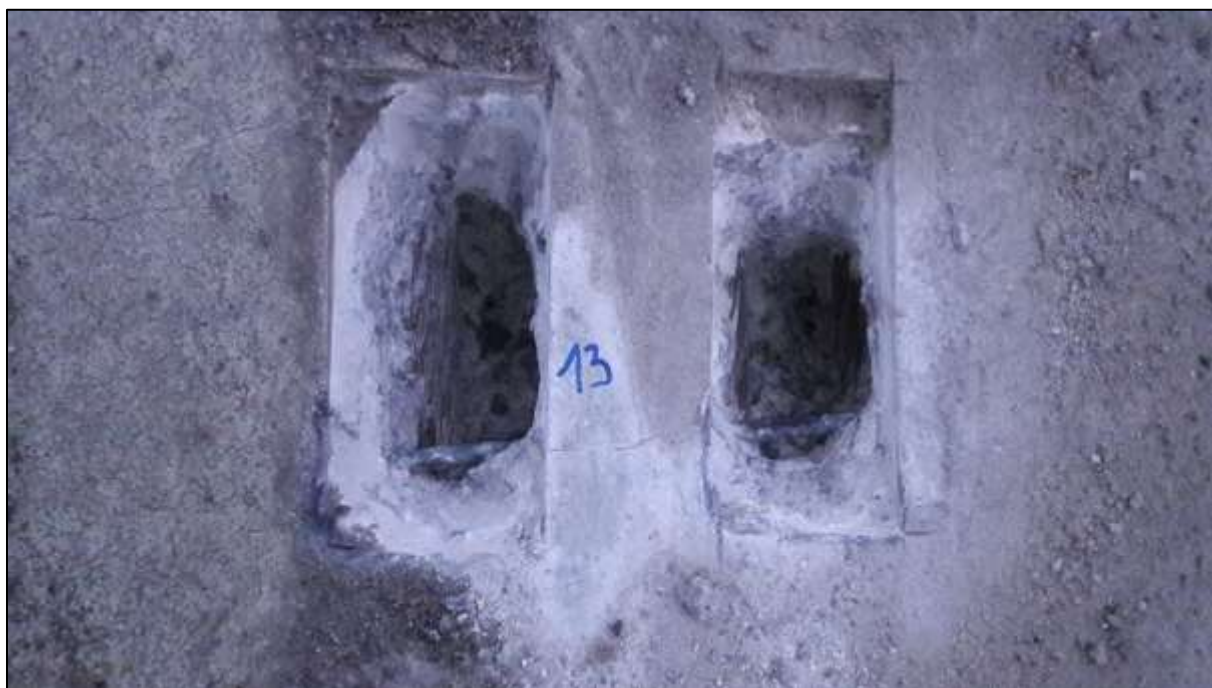
Foto 104: Pohled na otevřenou semidestruktivní sondu ke kabelům „systému A“ v pravé rýze, spára 13, kabel P 1- 2 a 2-3
