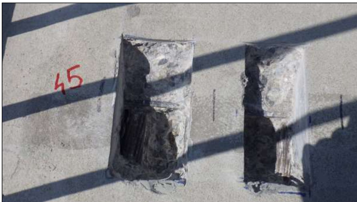
Foto 116: Pohled na otevřenou semidestruktivní sondu ke kabelům „systému A“ v levé rýze, spára 45, kabely L 1-2 a 2-3
