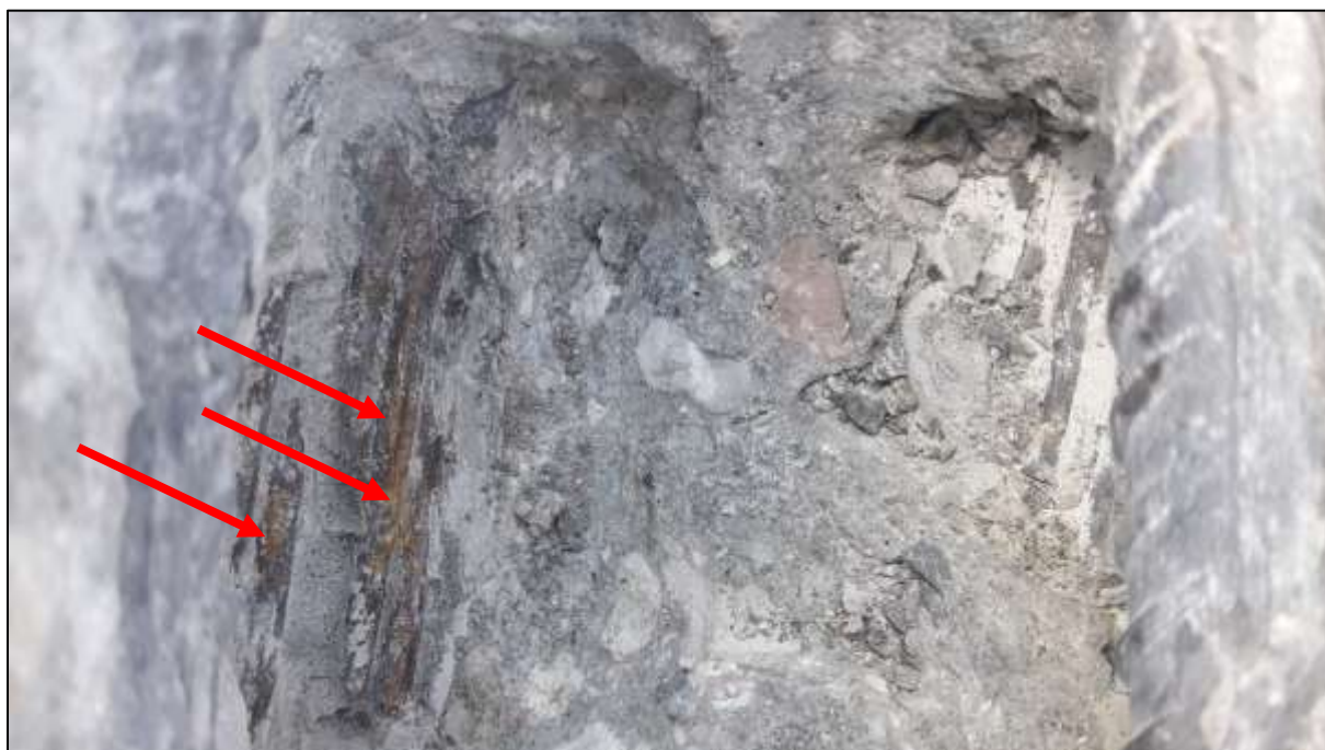
Foto 51: Pohled do otevřené sondy, počátky koroze mezi dráty lan kabelu 10 (vlevo), světlá injektáž kanálku lana 11 (vpravo), bez známek koroze
