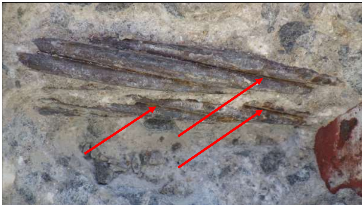
Foto 137: Bližší pohled na korozní stav odkrytých předpínacích lan kabelu L 2, nesouvislá slabá povrchová koroze, místy propagace koroze ze štěrbiny mezi patentovými dráty (viditelné dutiny mezi dráty)
