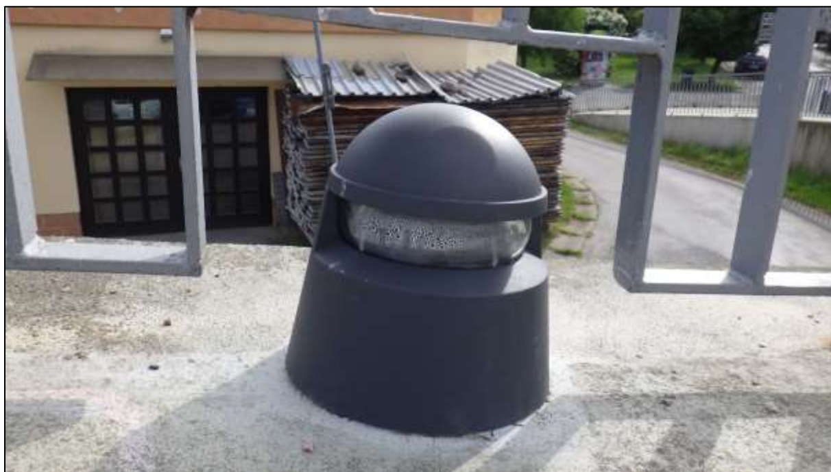
Foto 6: Bližší pohled na kondenzaci uvnitř plastového tělesa svítidla
