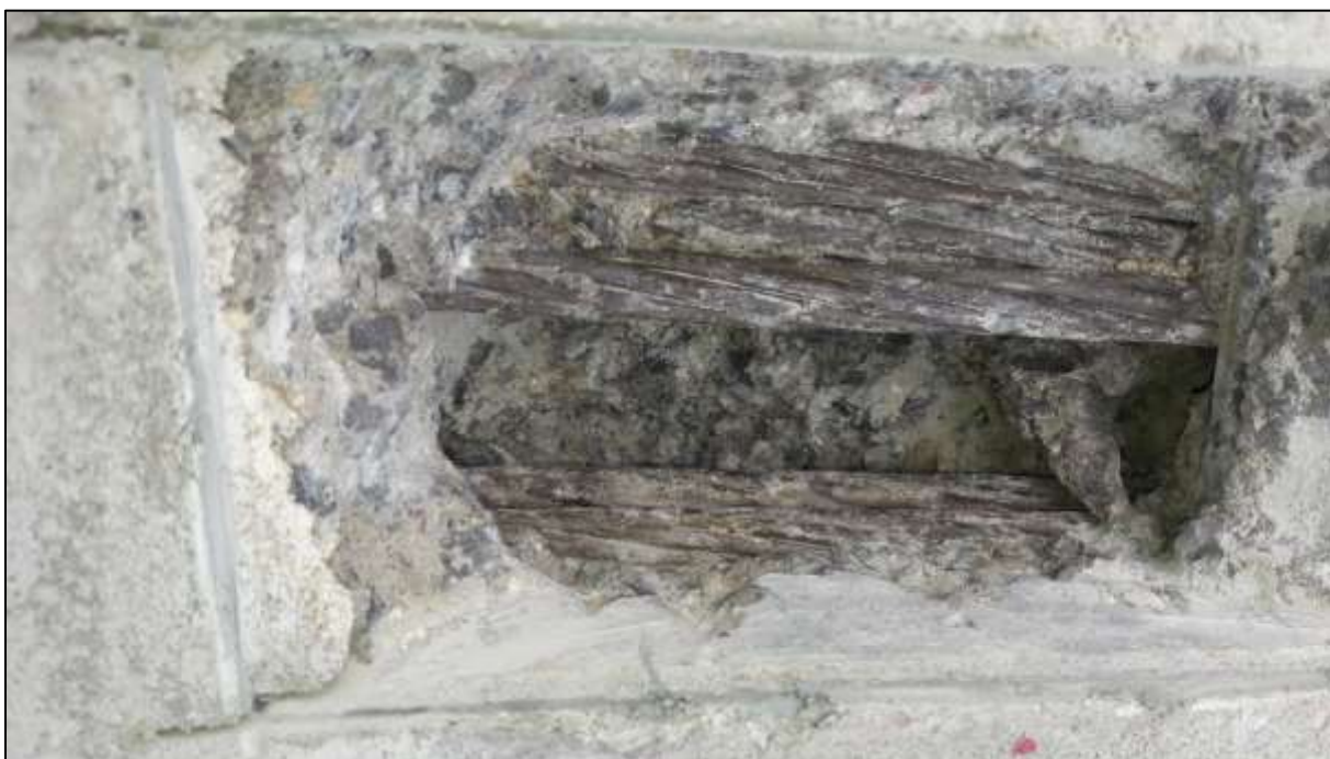
Foto 68: Bližší pohled na korozní stav kabelů L 1 a 2, pouze nevýrazná lokální povrchová koroze
