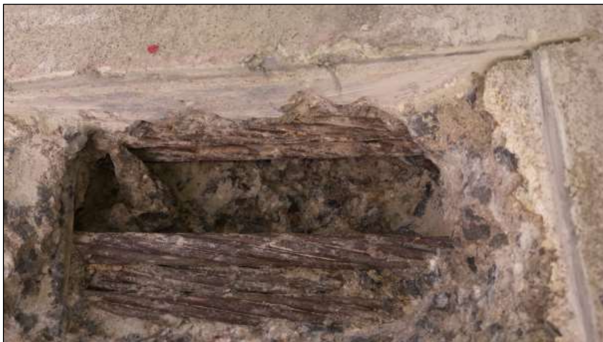
Foto 70: Pohled na korozní stav kabelů L 1 a 2, po zvýraznění kontrastu navlhčením povrchu
