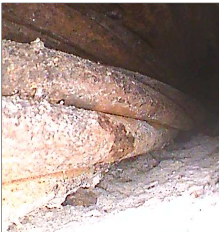
Foto 83: Detailní pohled na lana kabelu P2, patrná koroze patentových drátů, směr spára 3, délka dutiny cca 40 cm od hrany sondy
