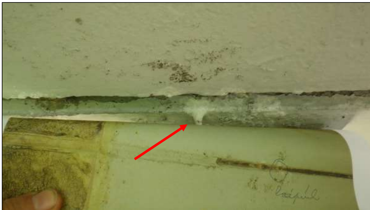
Foto 28: Pohled na detail krápníčku, v současné chvíli neaktivní – bez kapky vody vlevo u příčné spáry 66
