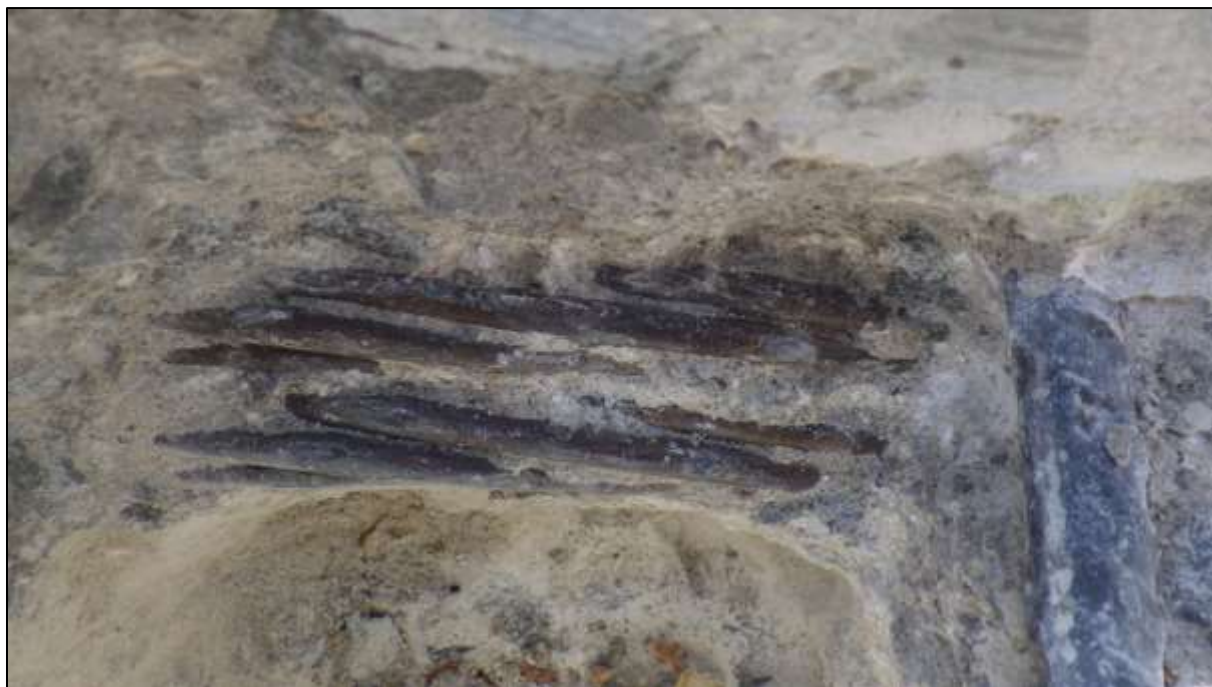
Foto 122: Bližší pohled na korozní stav odkrytých předpínacích lan kabelu L 1, souvislá povrchová koroze, místy propagace koroze ze štěrbin mezi patentovými dráty
