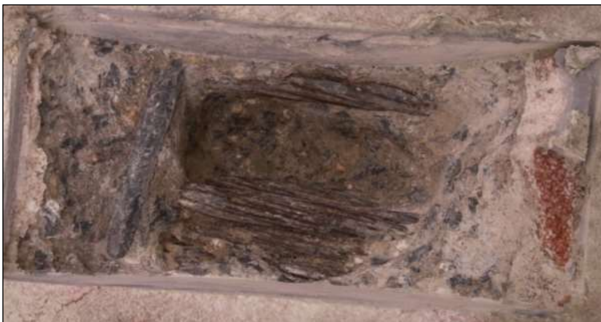
Foto 100: Zvýraznění barevného kontrastu po navlhčení povrchu odkrytých předpínacích lan kabelů L 1 a 2, dobře zřetelná propagace koroze ze štěrbiny mezi patentovými dráty
