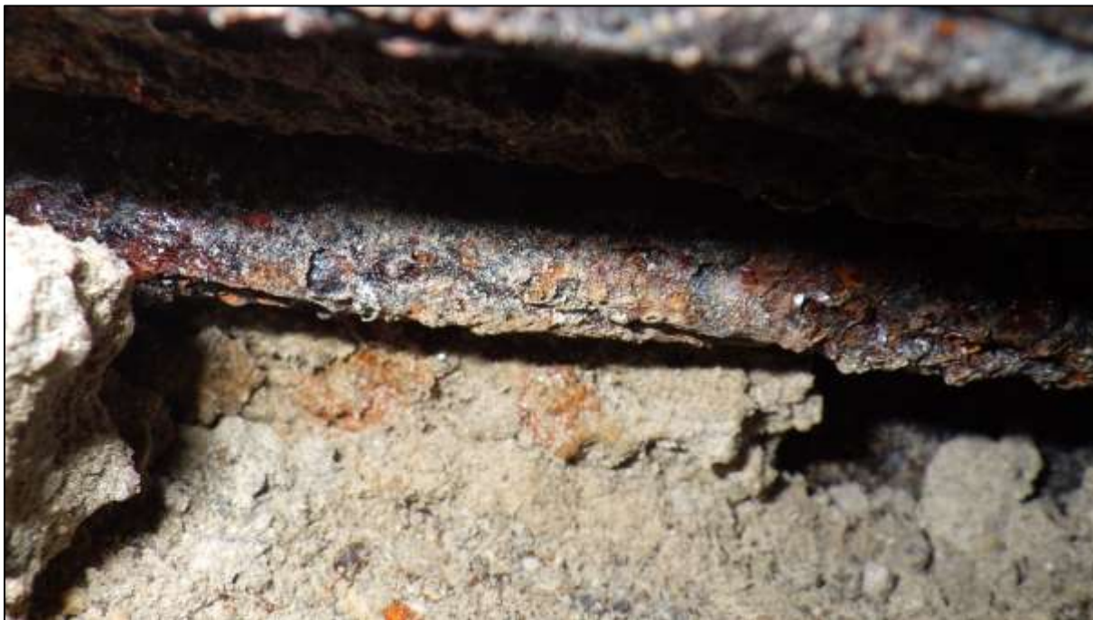
Foto 79: Pohled na rozvinutý korozní stav spodního lana kabelu P3 a dutinou pod ním a nehtný světlým betonem výplně rýhy
