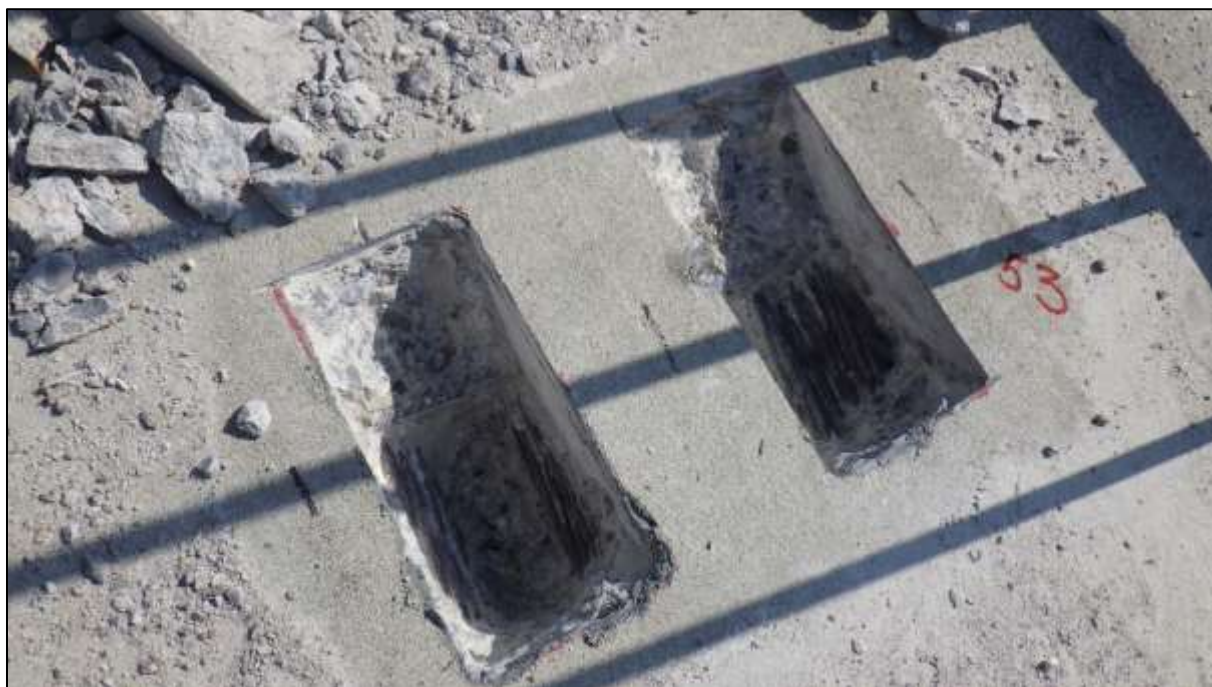
Foto 132: Pohled na otevřenou semidestruktivní sondu ke kabelům „systému A“ v levé rýze, spára 53, kabely L 1-2, 3
