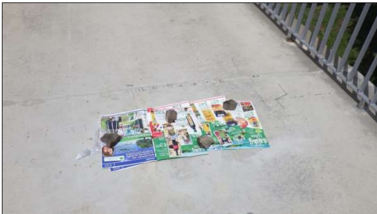
Foto 42: Vícevrstvé zakrytí – vlhké ošetřování provedené reprofilace v době tuhnutí a počátku tvrdnutí (48 hod.)
