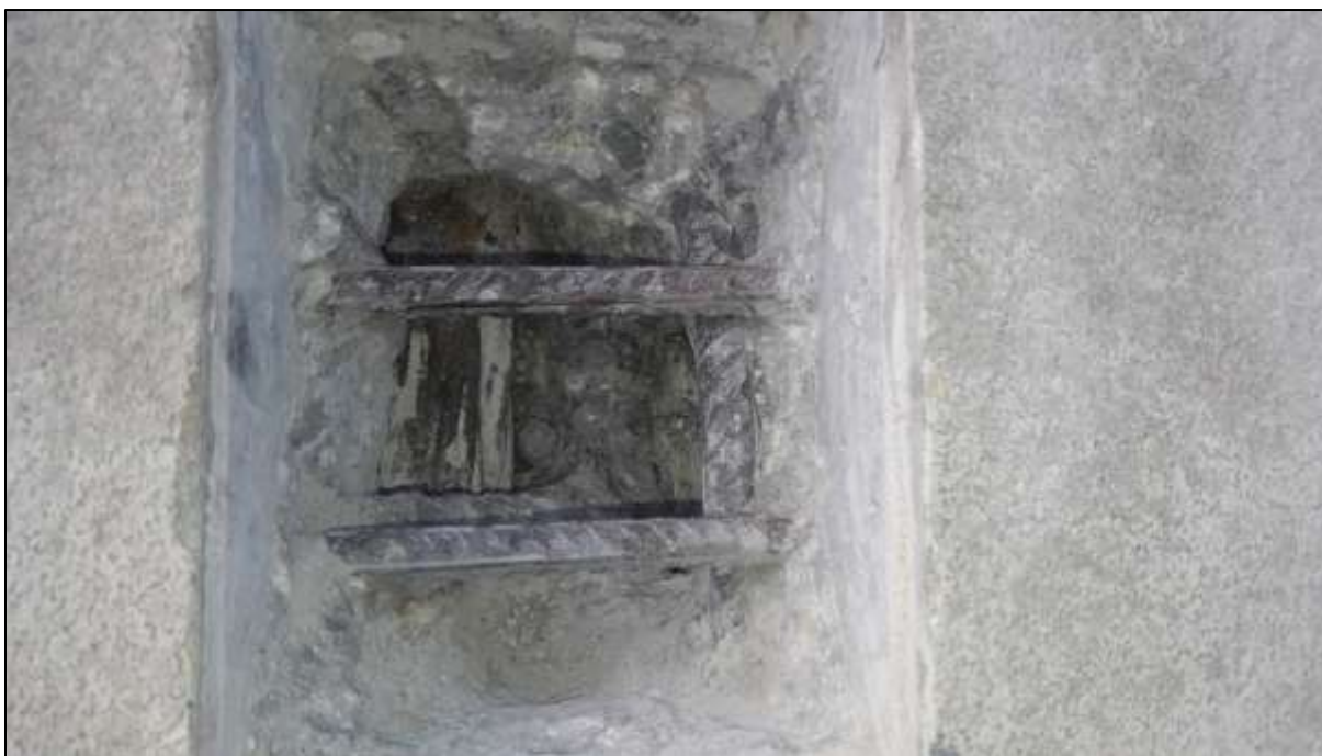
Foto 55: Semidestruktivní sonda ke kabelu „systému B“ v kanálku, prefabrikát 11-12, mezi kanálky 7 a 8
