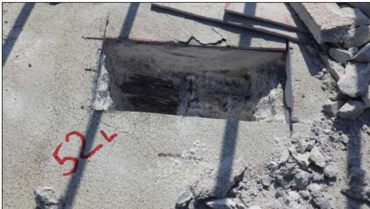
Foto 129: Pohled na otevřenou semidestruktivní sondu ke kabelům „systému A“ v levé rýze, spára 52, kabely L 1-2
