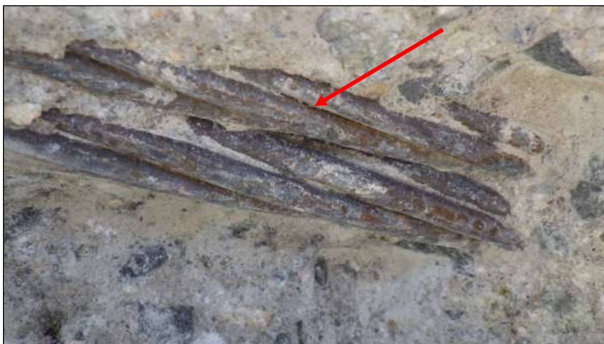
Foto 134: Bližší pohled na obdobný korozní stav lan kabelu L 1, nesouvislá povrchová koroze, místy propagace koroze ze štěrbin mezi patentovými dráty
