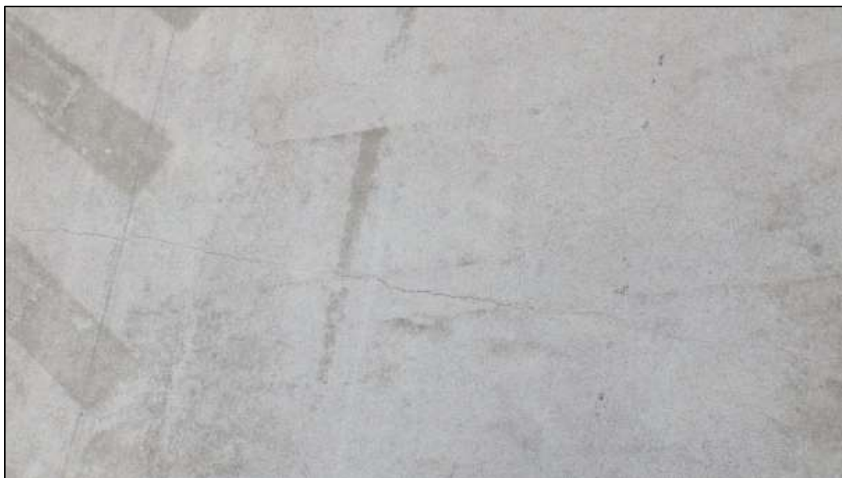
Foto 9: Charakteristický průběh trhliny ve stěrkovém systému, prakticky obdobný u všech příčných styčných spár prefabrikátů lávky
