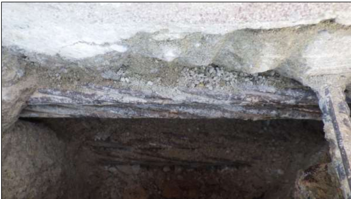
Foto 80: Pohled do sondy shora na kabely P2 a 4 s dutinou mezi vrstvami
