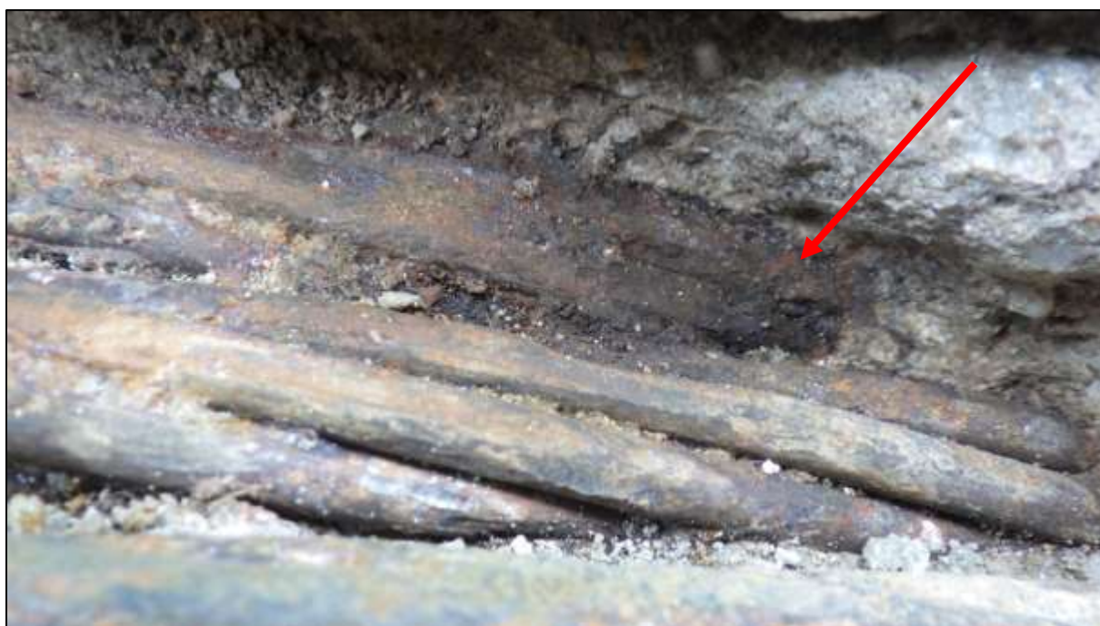
Foto 78: Detail výrazně korozně oslabených drátů horního předpínacího lana kabelu P3
