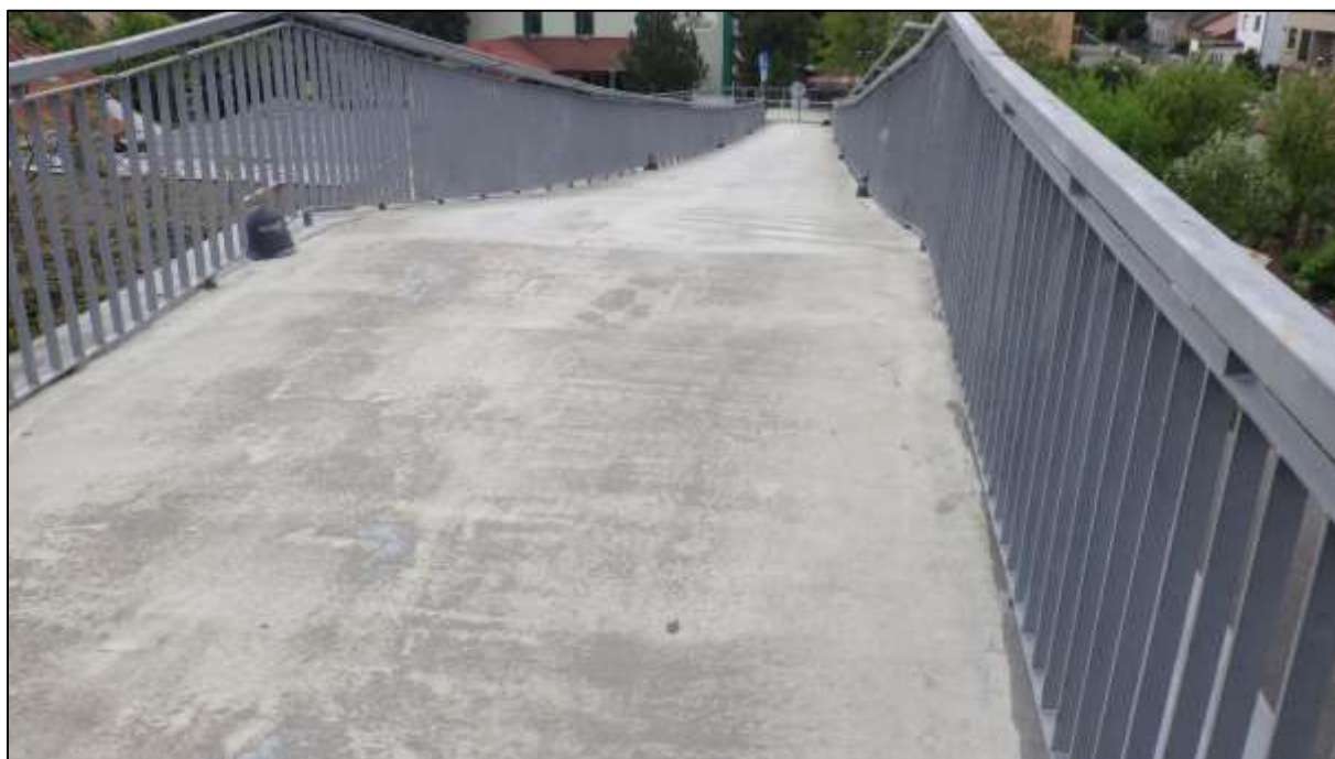
Foto 14: Pohled Přes pilíř 2 zpět ke kotevnímu bloku 1, výrazná deformace zábradlí na obou stranách a velké nerovnosti povrchu mostovky
