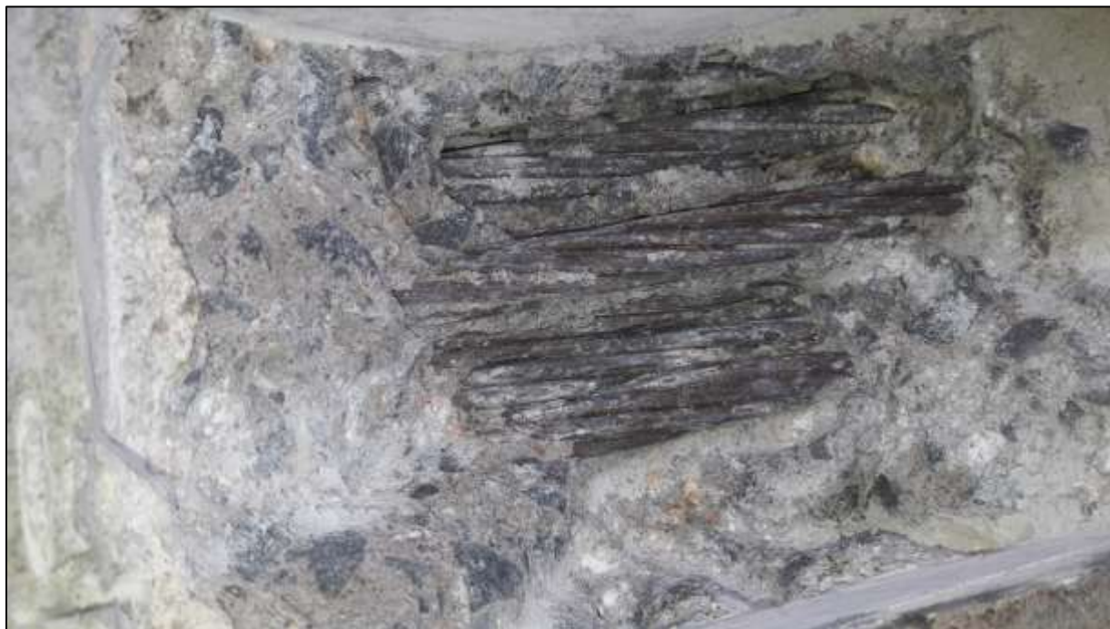
Foto 91: Bližší pohled na korozní stav předpínacích lan kabelu L2, mírná lokální povrchová, místy počínající důlková koroze, lokálně slabší propagace koroze ze štěrbiny mezi patentovými dráty
