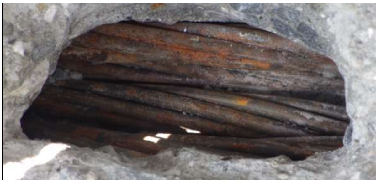
Foto 66: Detail stavu rozvoje povrchové koroze drátů lana 14, s viditelně aktivní korozí na štěrbinách mezi nimi
