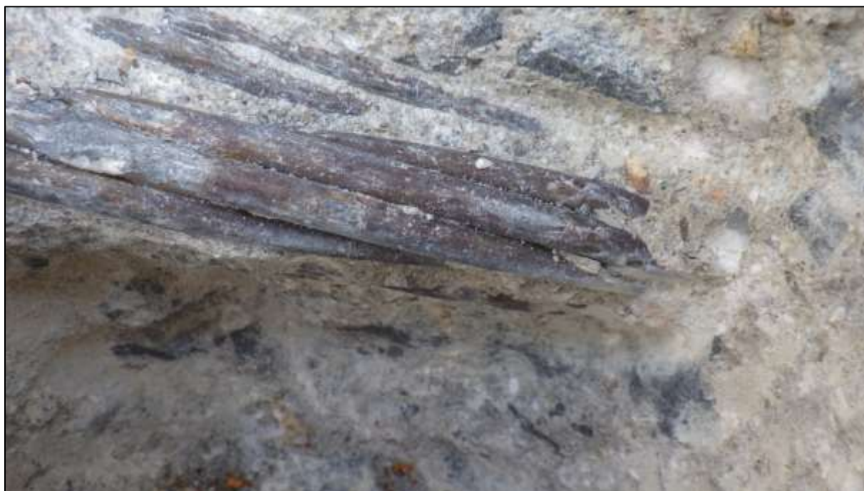
Foto 123: Bližší pohled na korozní stav odkrytých předpínacích lan kabelu L 1, nesouvislá povrchová koroze, místy propagace koroze ze štěrbin mezi patentovými dráty
