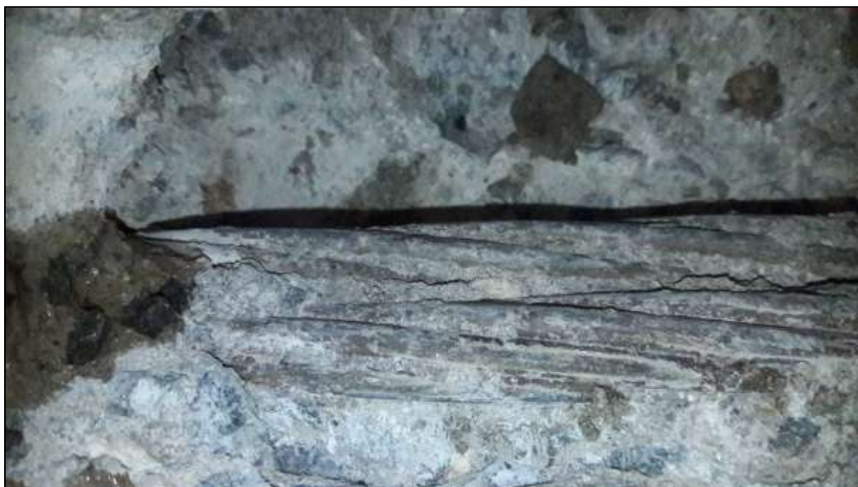
Foto 106: Bližší pohled na korozní stav odkrytých předpínacích lan kabelů P1, nesouvislá povrchová koroze, místy naznačená důlková, nehtný a trhlinami porušený výplňový beton rýhy kolem kabelu
