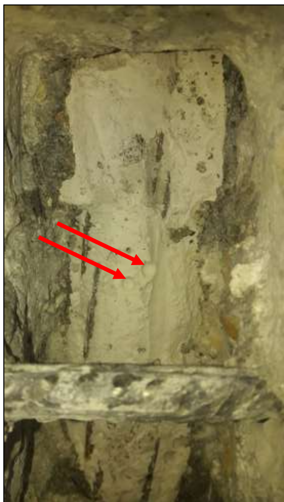
Foto 44: Semidestruktivní sonda ke kabelu „systému B“ v kanálku, prefabrikát 2-3, kanálek 1, odebraný vzorek betonu a injektáže
