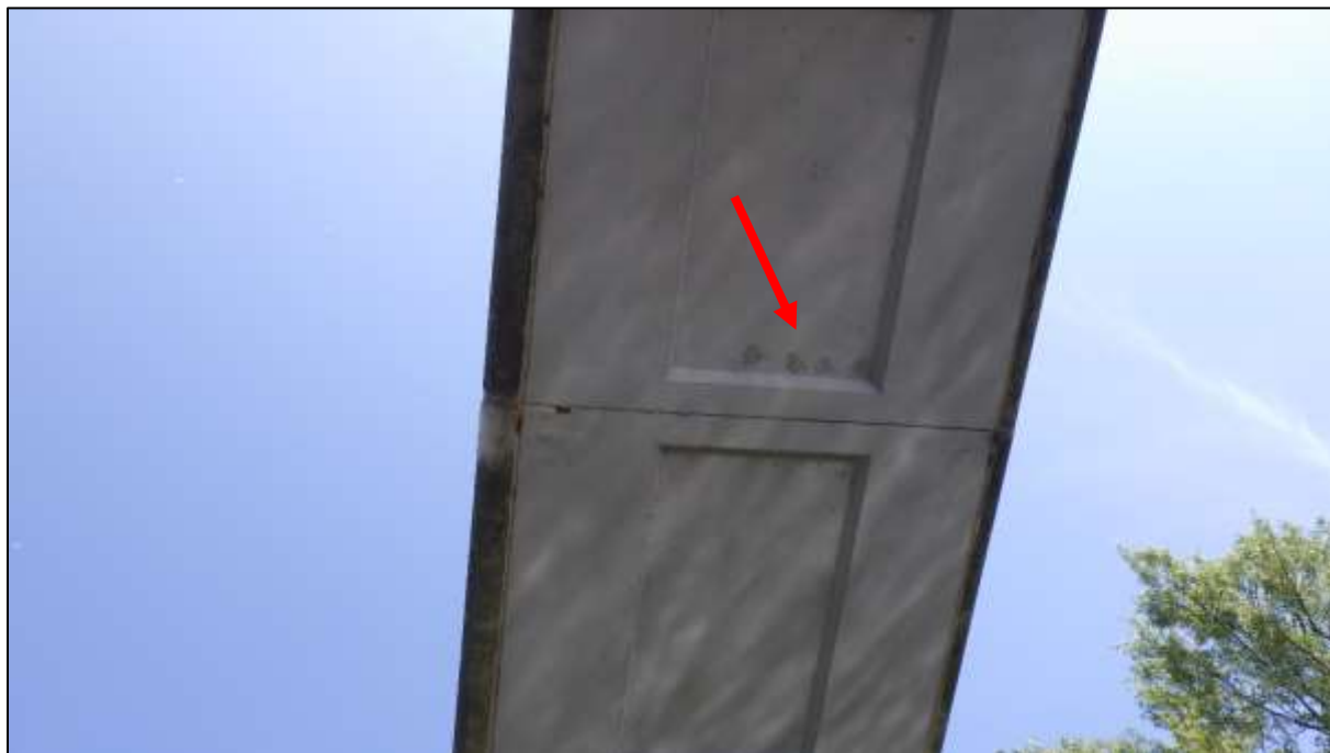
Foto 31: Pohled na dříve provedené sondy k lanům „systému B“ [2], prefabrikát 43-44 středního pole, u spáry 44
