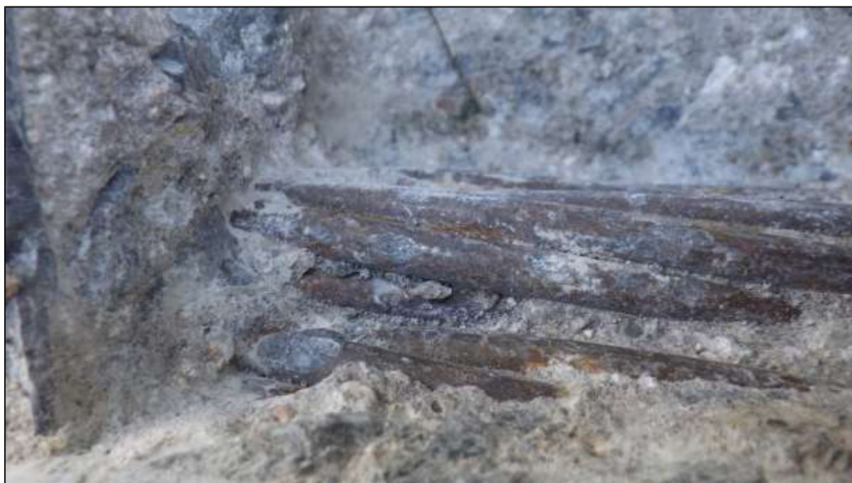
Foto 118: Bližší boční pohled na korozní stav odkrytých předpínacích lan kabelu L 2 nesouvislá povrchová koroze, lokálně počínající propagace koroze ze štěrbiny mezi patentovými dráty
