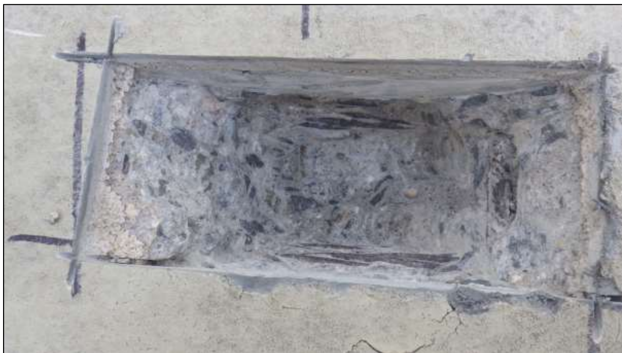
Foto 144: Pohled na otevřené semidestruktivní sondy ke kabelům „systému A“ v pravé rýze, prefabrikát 69-70, kabely P 2-3, slabá nesouvislá povrchová koroze u patentových drátů obou kabelů
