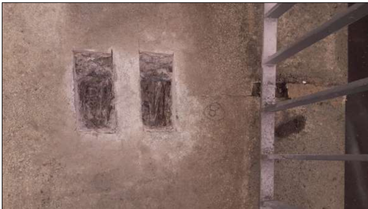
Foto 93: Pohled na otevřenou semidestruktivní sondu ke kabelům „systému A“ v pravé rýze, spára 8, kabel P 1- 2 a 2-3
