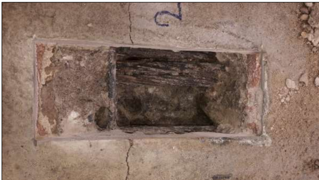
Foto 73: Pohled na otevřenou semidestruktivní sondu ke kabelům „systému A“ v pravé rýze, spára 2, mezi kabely P 2-3
