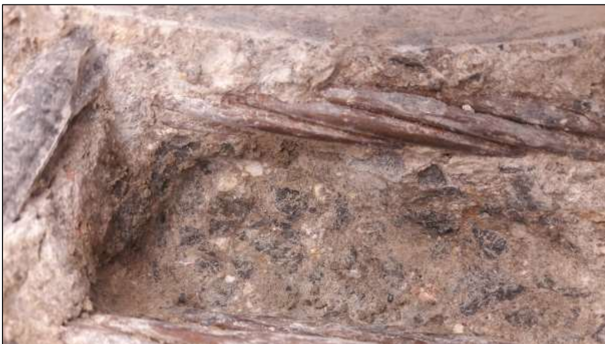
Foto 99: Blížeší pohled na korozní stav odkrytých předpínacích lan kabelu L 2, obdobný jako u L1 ve stejné sondě
