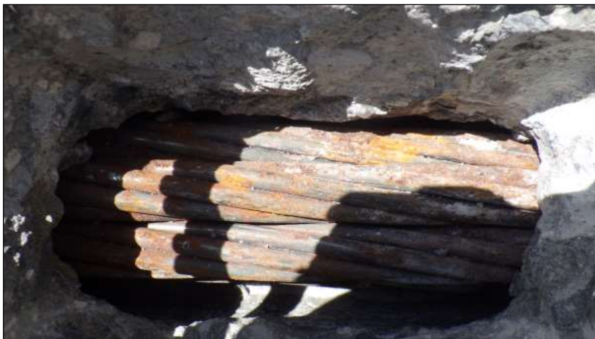
Foto 62: Detailní pohled na sondou zjištěné různé fáze koroze patentových drátů předpínacích lan kabelu 8, dobře rozlišitelné při přímém oslnění sondy
