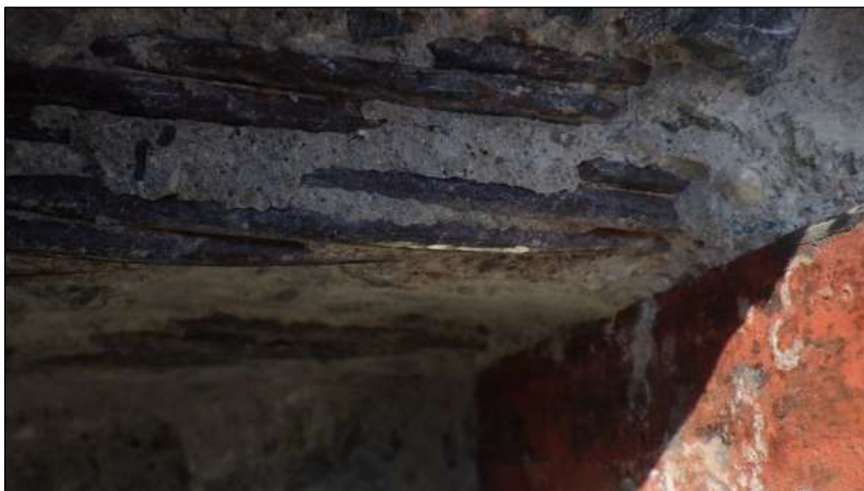
Foto 141: Bližší boční pohled na korozní stav odkrytých předpínacích lan kabelu L 2 a 4, ve spáře 66, nesouvislá povrchová koroze, místy propagace koroze ze štěrbin mezi patentovými dráty
