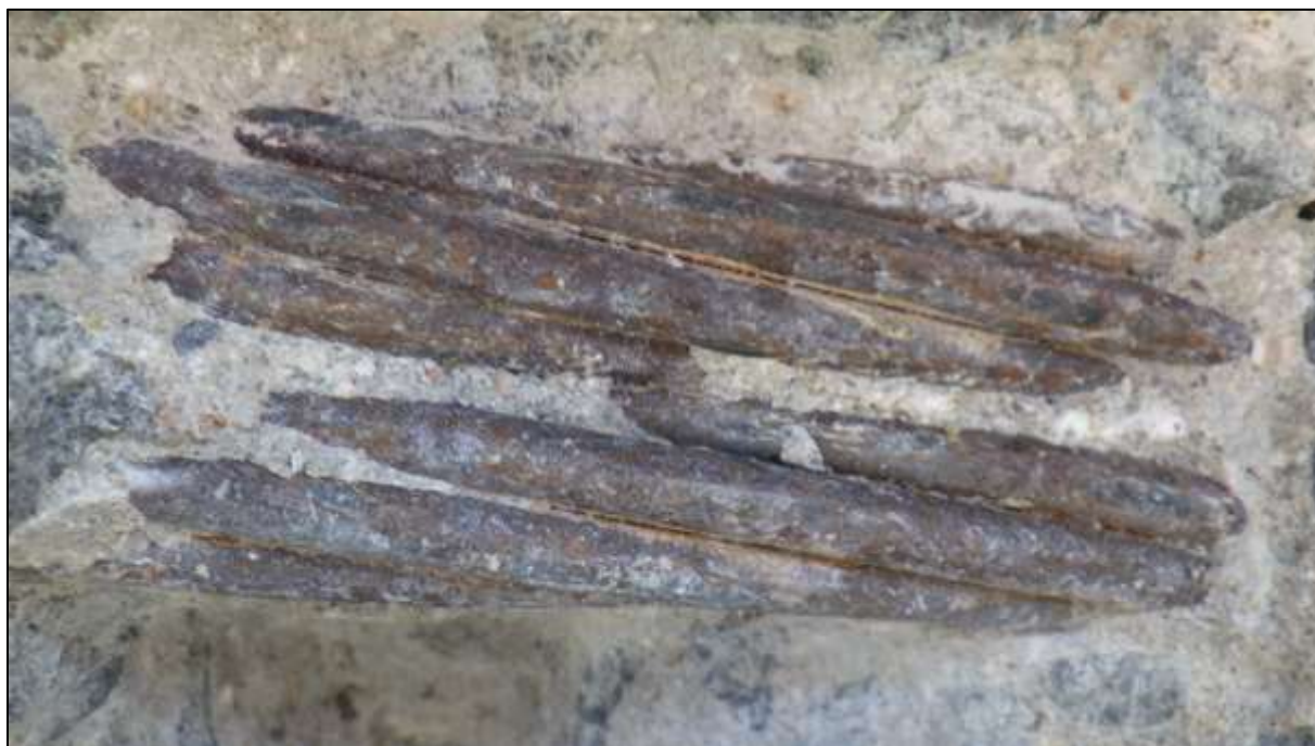
Foto 138: Bližší pohled na korozní stav odkrytých předpínacích lan kabelu L 3, obdobný stav, slabá nesouvislá povrchová koroze, místy propagace koroze ze štěrbiny mezi patentovými dráty (viditelné dutiny mezi dráty)
